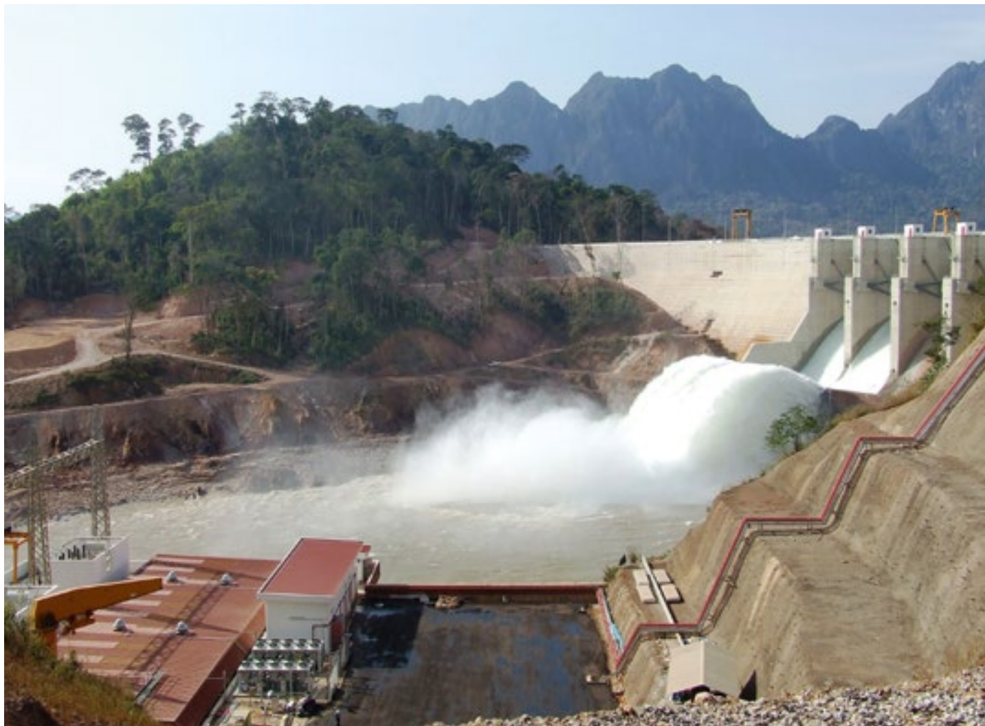
Laotiske Theun-Hinboun Power Company (THPC), der Statkraft eier 20 prosent, åpnet i januar 2013 to nye kraftstasjoner. I likhet med den eksisterende kraftstasjonen som sto ferdig i 1998 skal også de nye stasjonene driftes og vedlikeholdes av Statkraft. Totalt vil utvidelsen doble produksjonen av fornybar energi til tre TWh per år.
