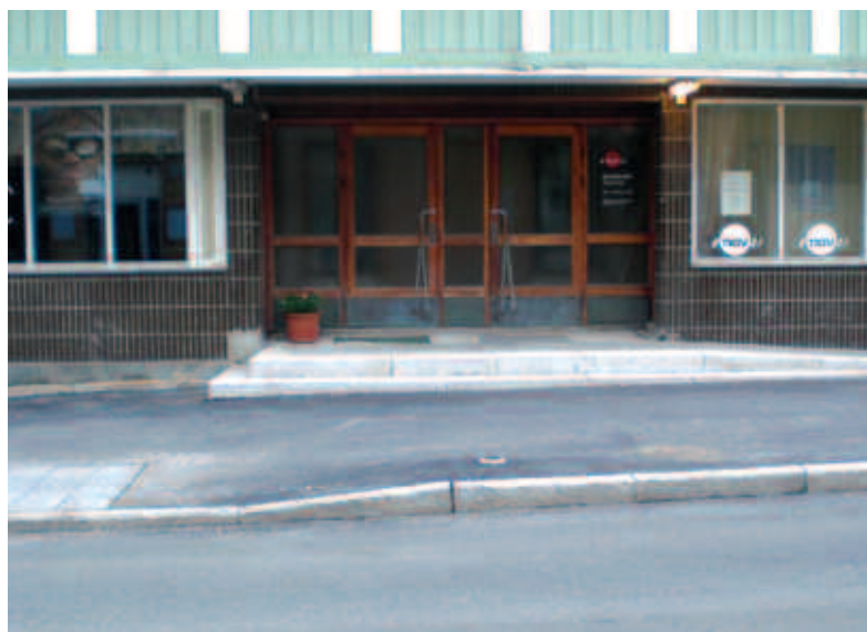
Nytt inngangsparti til forretning i Båtsfjord. Foto Line Røtvold
