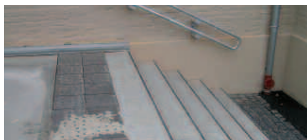
Markering av trappeneser samt varselfelt. Foto: Karen-Anne Noer/Kongsvinger kommune
