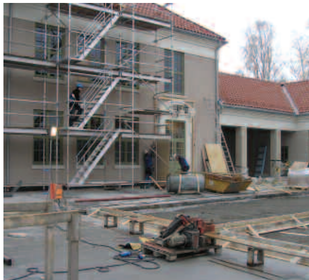
Inngangen før og etter ombygging. Skoleplassen er hevet for å gi trinnfri adkomst. Foto: Arnljot Bringedal/Kongsvinger kommune og Karen-Anne Noer/Kongsvinger kommune
