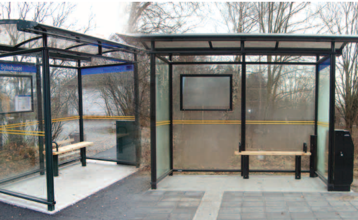
Utforming av buss-skur. Her er eksempler fra Gjøvik (til venstre) og fra Porsgrunn, hvor det også er lagt inn ledelinje. Foto: Hans Petter Olsen (Gjøvik) og Kjersti Berg/Porsgrunn kommune
