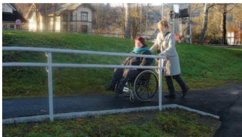
Naturlig rampe. Foto: Solveig Dale/Trondheim kommune
