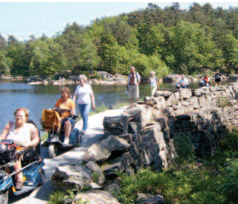
Bildet viser restaurert dam ved Jegersbergvannet i Kristiansand. Stien på dammen inngår i mer enn 10 mil med tilrettelagte turveier i kommunen. Foto: Per Svein Staalesen
