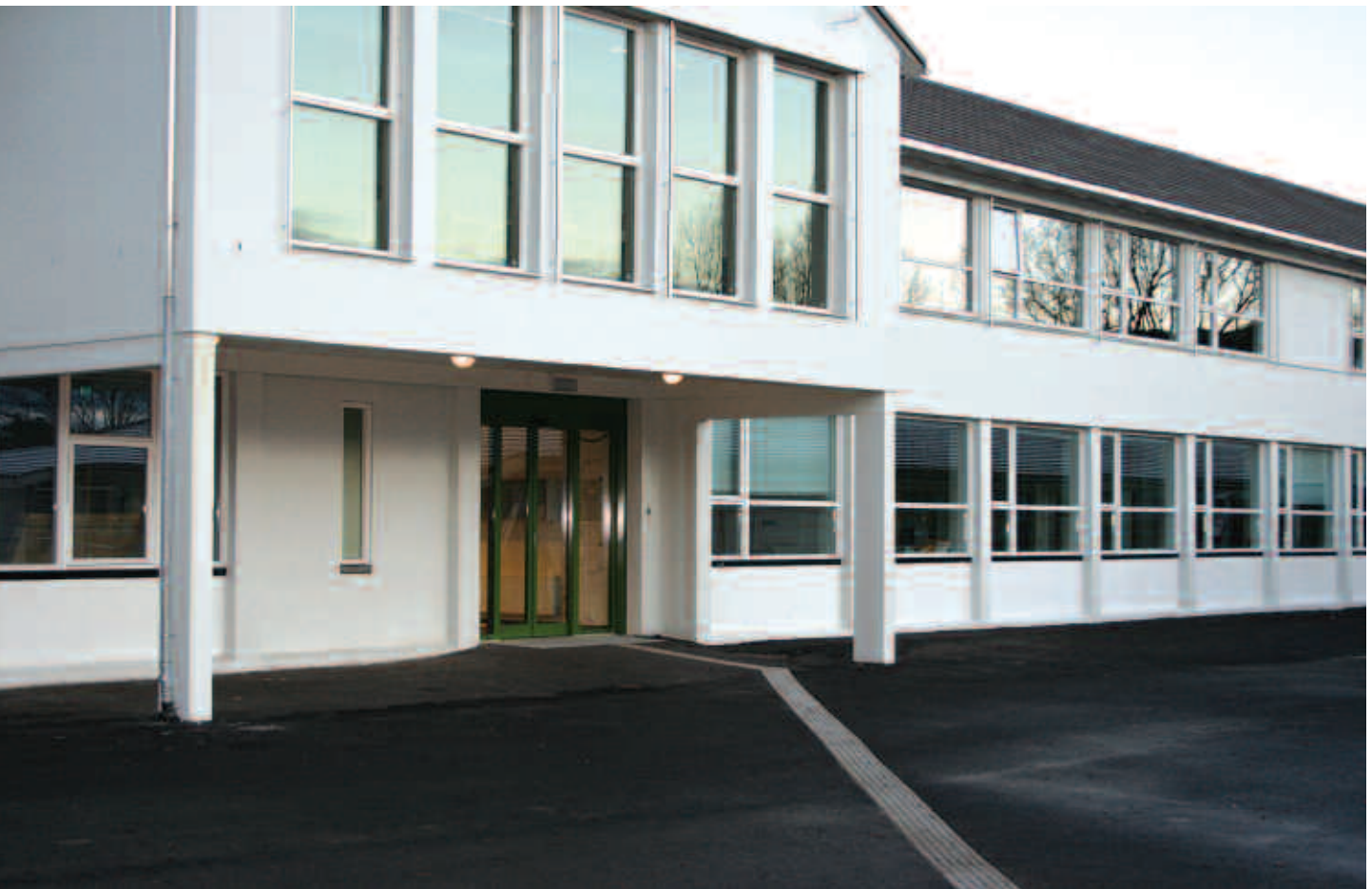
Frøyland skule – rehabilitert med universell utforming som rettesnor.
