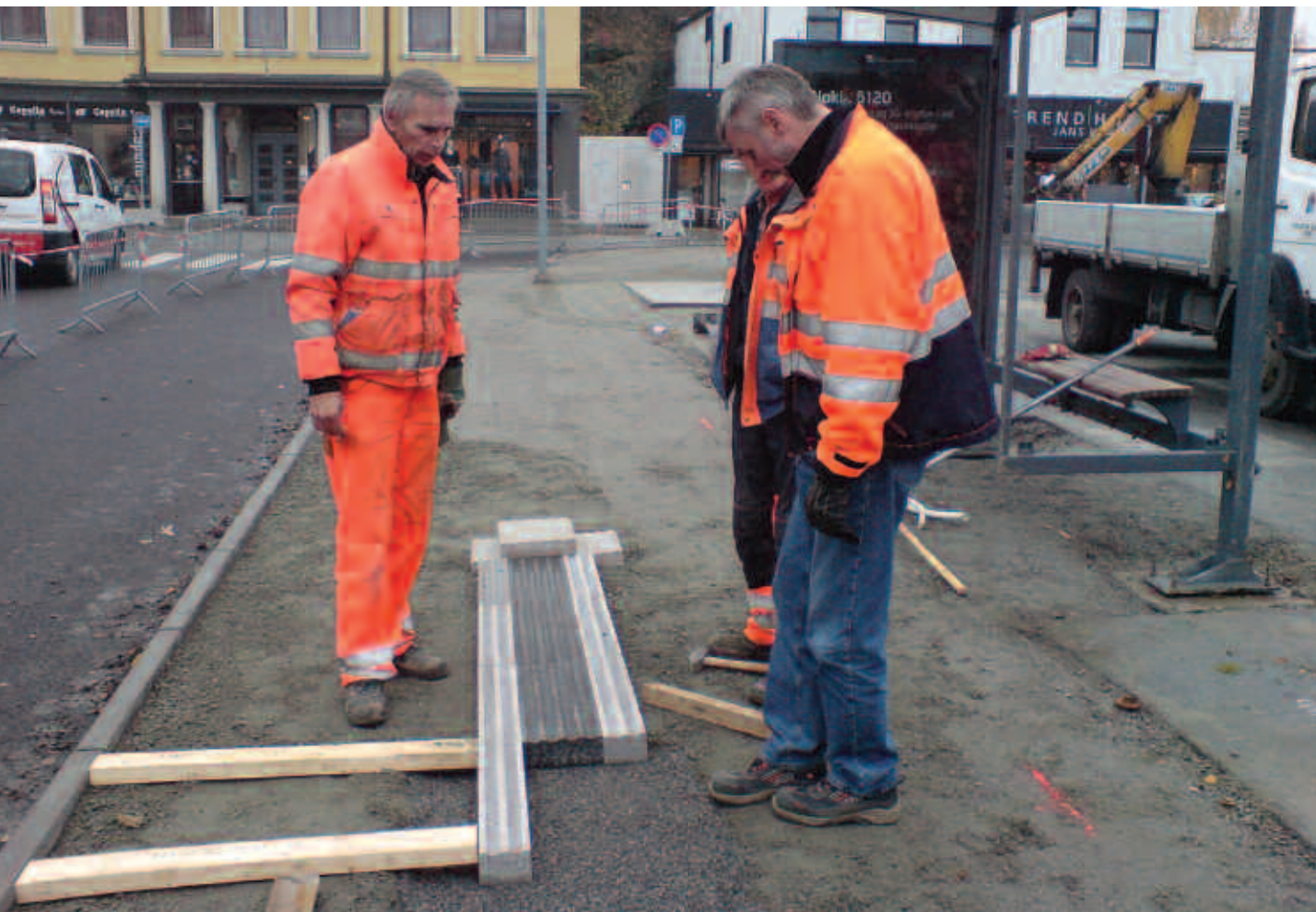
Porsgrunn sentrum, prøvefelt for ledelinjer for uttesting i forhold til drift, vedlikehold og funksjonalitet. Foto: Elin K. Gundersen/Asplan Viak
