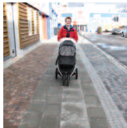
I den nye standarden for utforming av gate-/fortausnett i Sortland, skal det legges et felt i midten der heller der det er lett å trille både barnevogn og rullestol, ledelinje for synshemmede til venstre før møbleringssonen ut mot gata. Foto: Kristine Røiri/Sortland kommune
