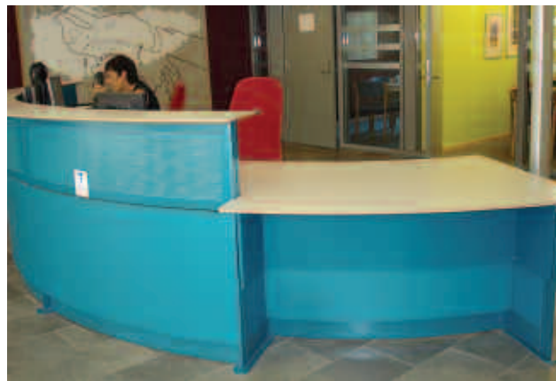
Skranke i to høyder og med tydelig fargeforskjell til gulvfarge. Skrankeslynge er montert foran på skranken og er vist med piktoqram.
