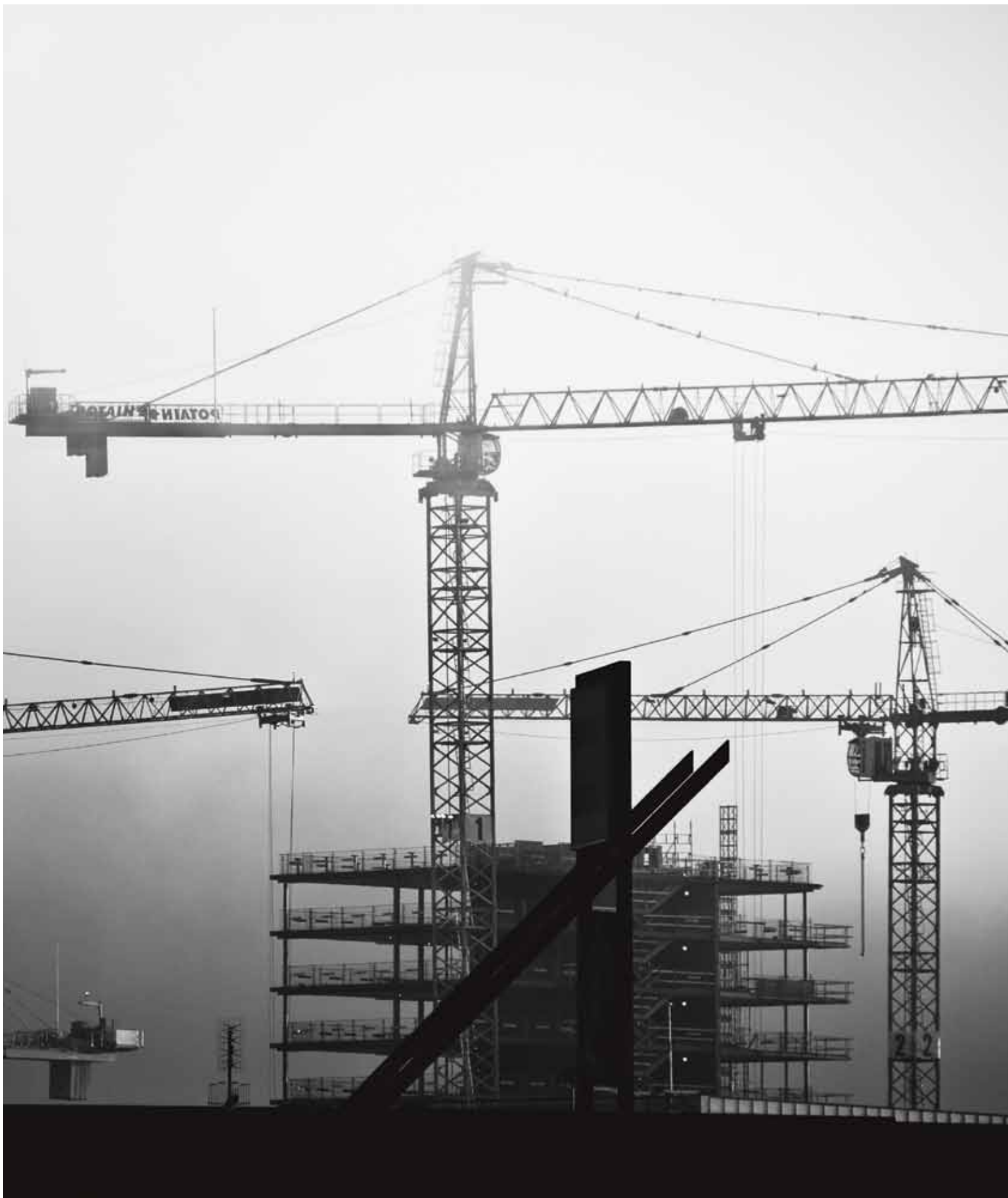
[0.7] Byggeplass. Bjørvika, Oslo
