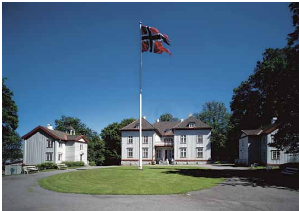
[3.6] Eidsvollbygningen fra 1770, Eidsvoll.
