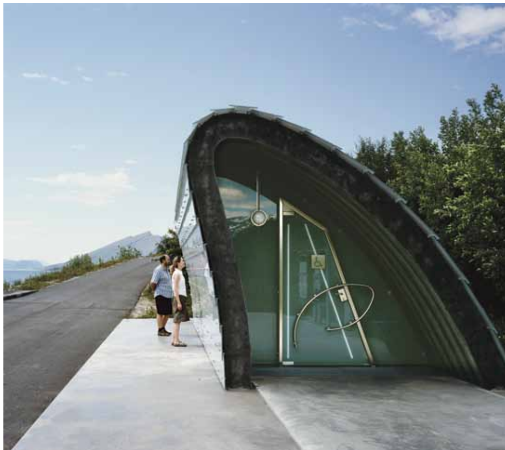
[5.5] Toalett- og servicebygg ved Hellåga rasteplass på Kystriksvegen ved Sjona i Rana kommune. Nasjonal Turistveg, Helgeland nord (Nordplan AS - Arild Waage)
