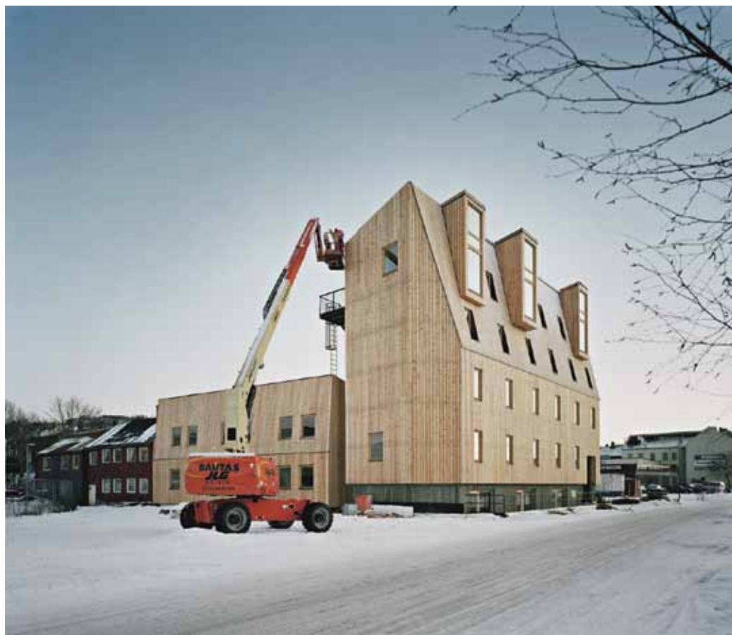
[1.5] Boliger i Strandveien 37-39. Trondheim (Brendeland og Kristoffersen Arkitekter AS)
