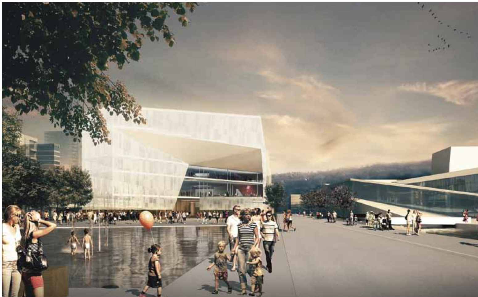
[5.3] Nye Deichmanske hovedbibliotek. Oslo (Lund Hagem Arkitekter / Atelier Oslo)
