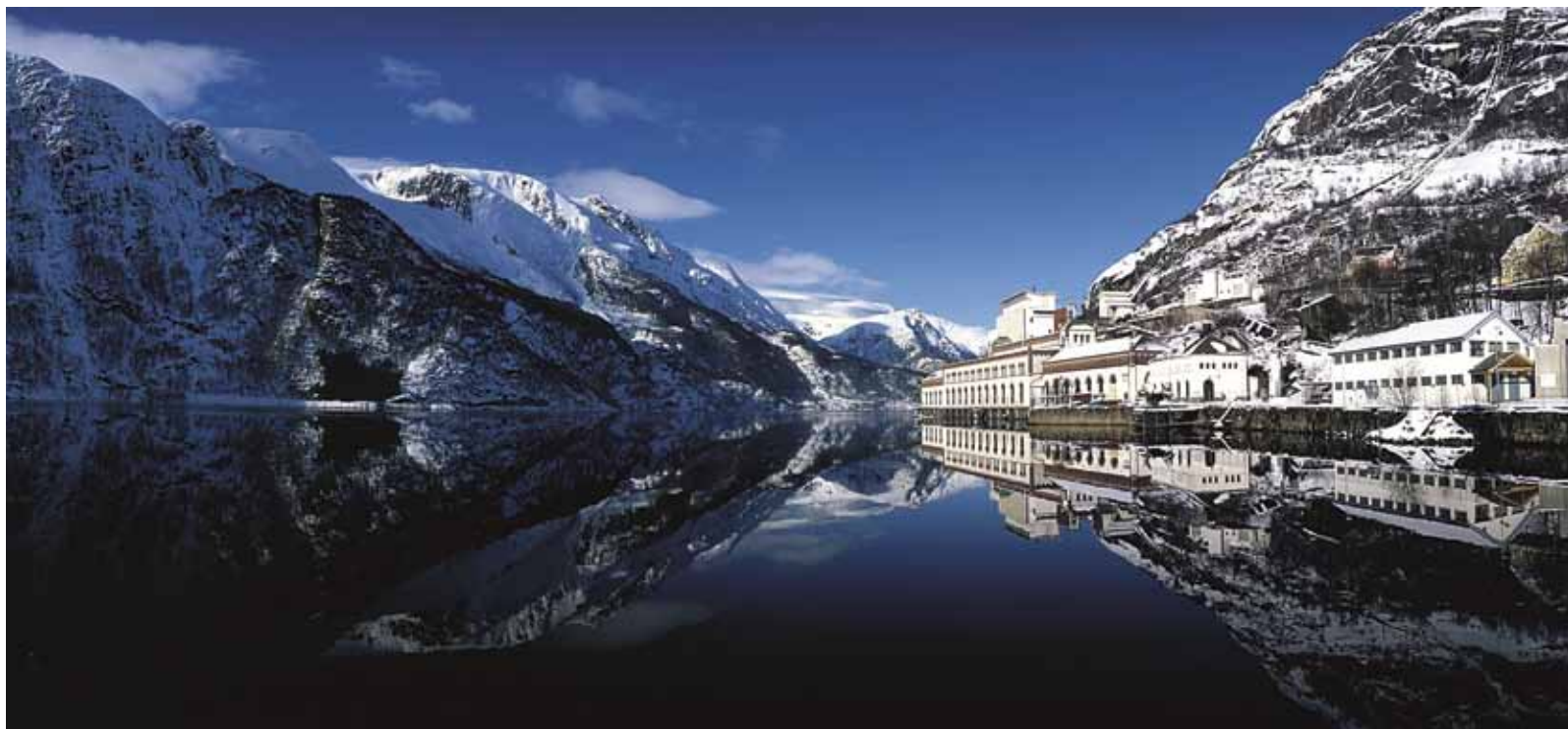
[2.7] Tyssedal kraftstasjon. Odda, Hordaland.
