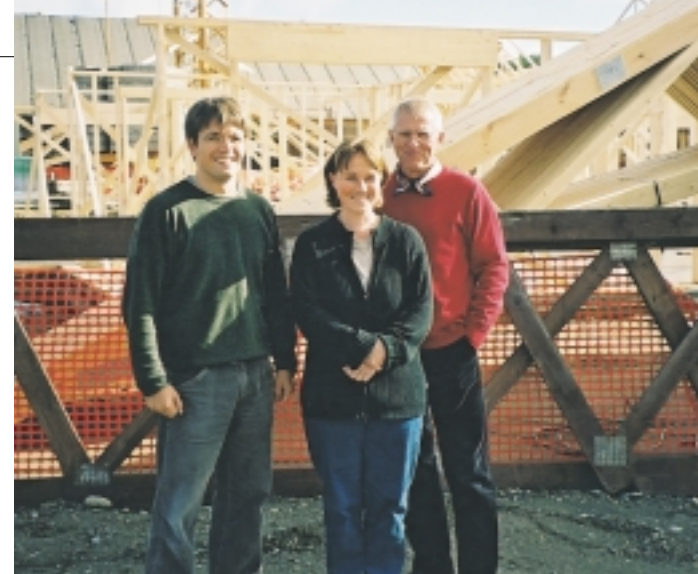
I Os bygges ny sykehjemsavdeling i tilknytning til eksisterende sykehjem. Turnuslege Tommy Alexander Valio, omsorgsleder Synnøve Narjord og kommunelege Helge Lund er fornøyd med framdriften.
