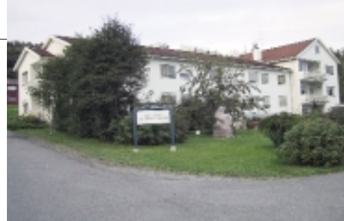
Ved Brøttum aldershjem vil Ringsaker kommune bygge en ny sykehjemsavdeling med 18 senger. Dagens aldershjem blir ombygget til 24 sykehjemsplasser.
