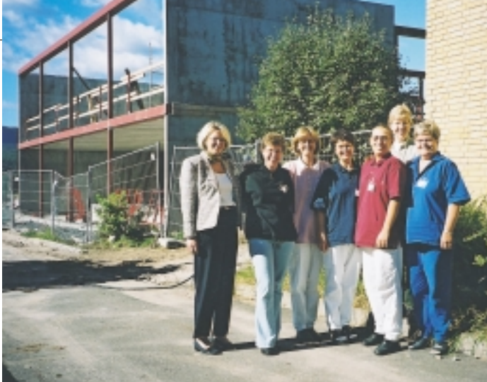
Hjemmesykepleiere i Våler kommune foran ny sykehjemsløy som er under bygging.
