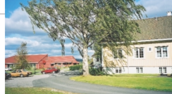
I Åsnes kommune er fortsatt det gamle Hof aldershjem i bruk. I bakgrunnen nye omsorgsboliger.
