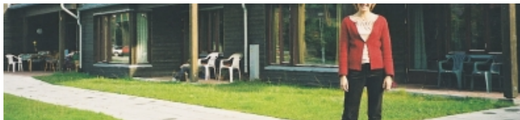
Klukstuen sykehjem for aldersdemente i Hamar er bygget med tilskudd fra Handlingsplan for eldreomsorgen.
