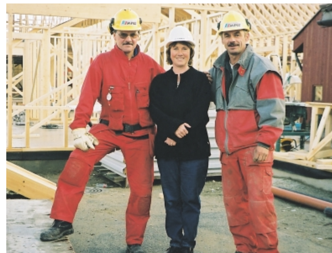
Handlingsplan for eldreomsorgen har medført en omfattende byggevirkosomhet i Hedmark. Her fra Os kommune hvor det bygges ny sykehjemsavdeling. Omsorgsleder Synnøve Narjord omgitt av snekkerene Hans Gøran Sundeberg til venstre og Kjell Snoen fra SK-Bbygg, Tynset.
