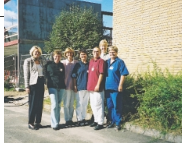
Omsorgsboliger på Skotterud bygget med midler fra Handlingsplan for eldreomsorgen. I bakgrunn Eidskog alders- og sykehjem som rehabiliteres.
