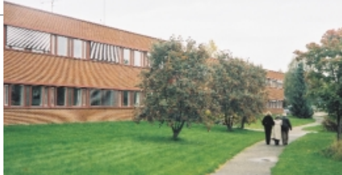
Ved Sør-Odal alders- og sykehjem skal det blant annet bygges en ny enhet for aldersdemente med 16 plasser.
