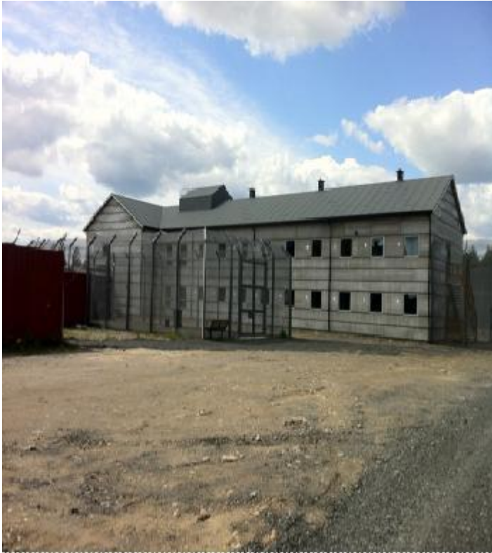
Modul 1 under bygging.
