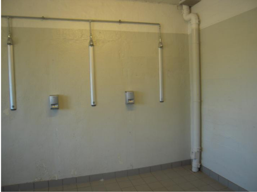
Fra ett av badene. Badet har vært pusset opp tidligere.
