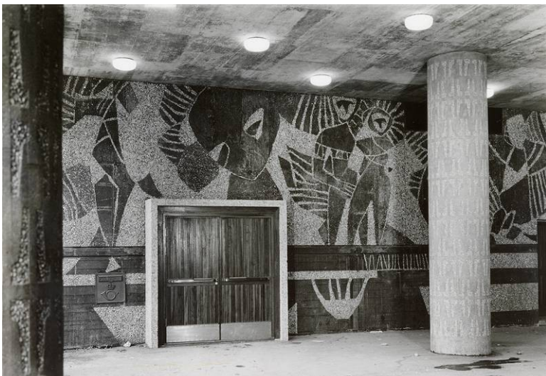
Kai Fjells utsmykning ved passasjen, senere vestibylen. Kilde: Byggekunst 1959
