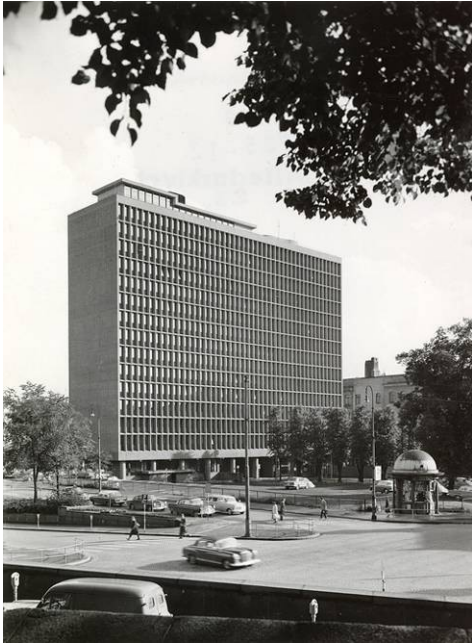
Høyblokken med opprinnelig avslutning og takoppbygg. Kilde: Arkitekturmuseets nettutstilling
