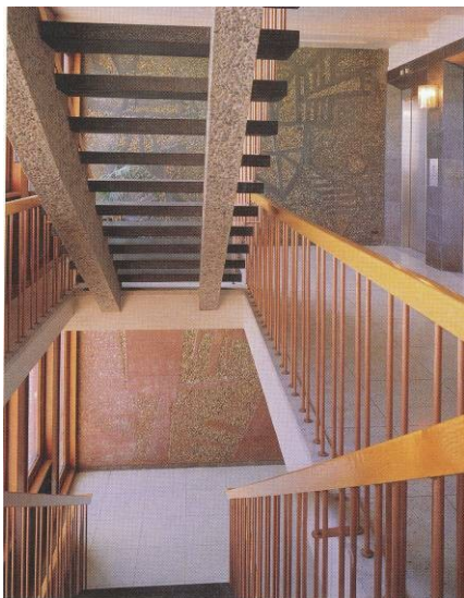
Trapperommet med fargevariasjon i betong. Kilde: Statsbygg, Regjeringskvartalet
