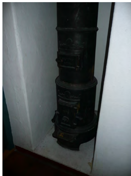
Nisje med ovn for opprinnelig oppvarming i kjelleretasjen. Opphavsrett: Statsbygg.
