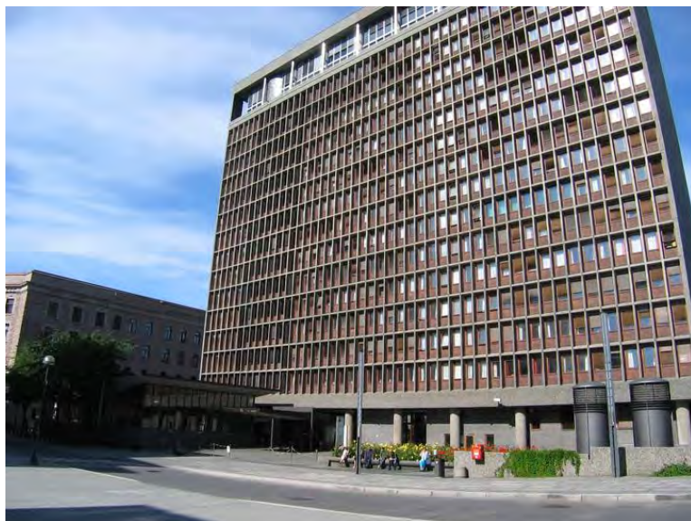
Høyblokkens østfasade med inngangspartiet fra Grubbegata. Kantinen til venstre. Bak den skimtes Gamle regjeringsbygning. Opphavsrett: Statsbygg.
