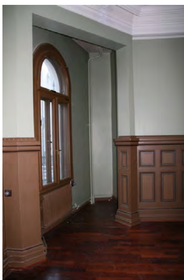
Originalt vindu og brystpanel. Opphavsrett: Statsbygg.
