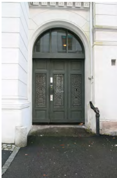
Detaljer på rehabilitert ytterdør. Opphavsrett: Statsbygg.
