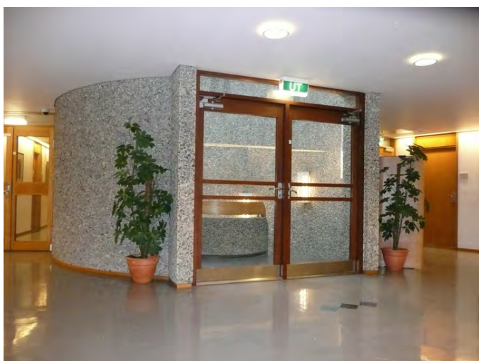
Originale dører mot hovedtrapperommet. Opphavsrett: Statsbygg.
