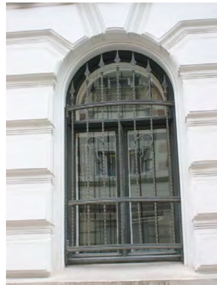
Vinduene med smijernsgitter og PP med henvisning til Peter Petersen. Opphavsrett: Statsbygg.
