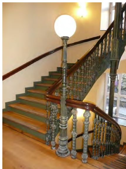
Ferdig restaurert hovedtrappeløp. Opphavsrett: Statsbygg.
