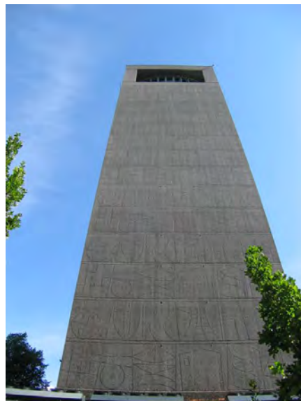
Fasaden mot syd med sine karakteristiske sandblåste relieffer i betongveggen. Opphavsrett: Statsbygg.
