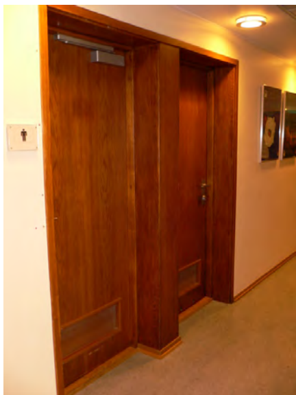
2. etasje. Trappedøra til venstre føyer seg inn i veggrytmen. Opphavsrett: Statsbygg.
