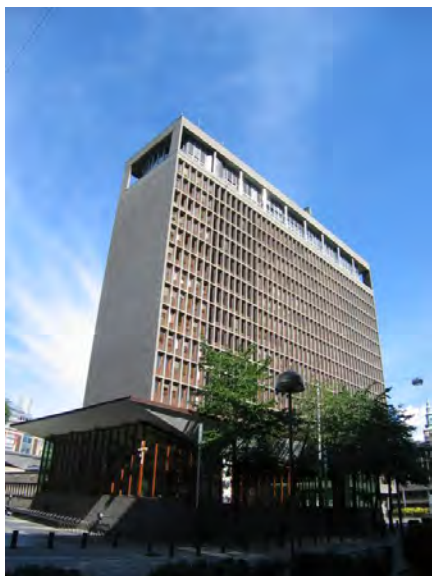
Høyblokken sett fra Grubbegata i retning nordvest. I forgrunnen den lave kantinedelen på en etasje. Opphavsrett: Statsbygg.
