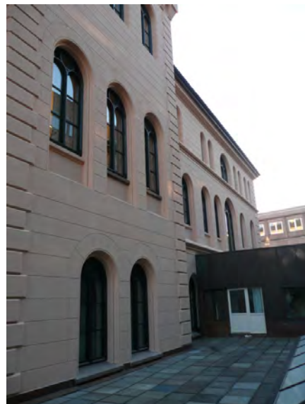
Fasade mot vest hvor Møllergata 19 er forbundet med S-blokka. Opphavsrett: Statsbygg.
