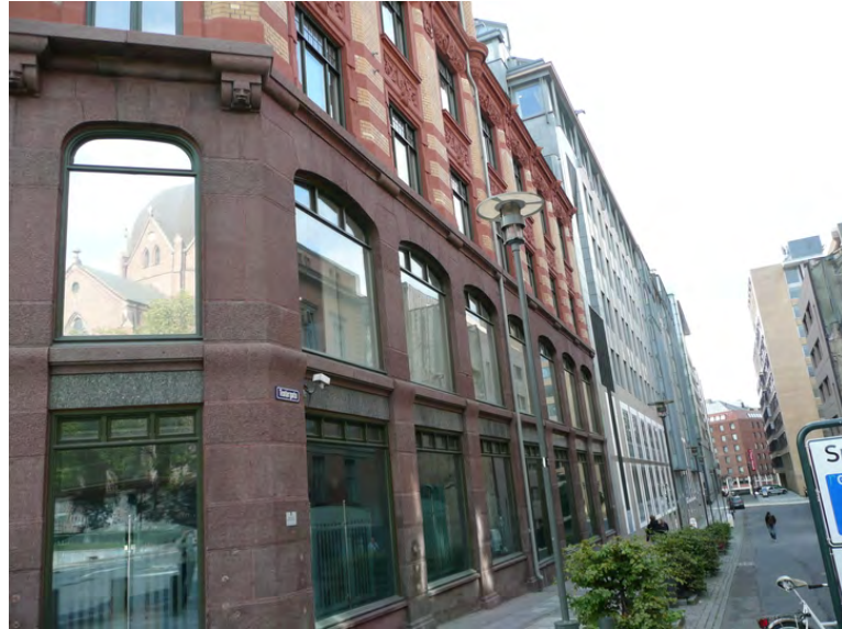
Fasade langs Teatergata. Togagårdens eksterior er bevart. Opphavsrett: Statsbygg.
