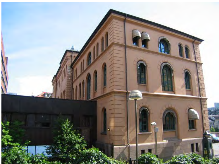
Bildet viser sørenden av bygget mot Eva Kolstads gate. Møllergata 19 er bygget sammen med S-blokka, og dette ble gjort i 1976-1978. Opphavsrett: Statsbygg.
