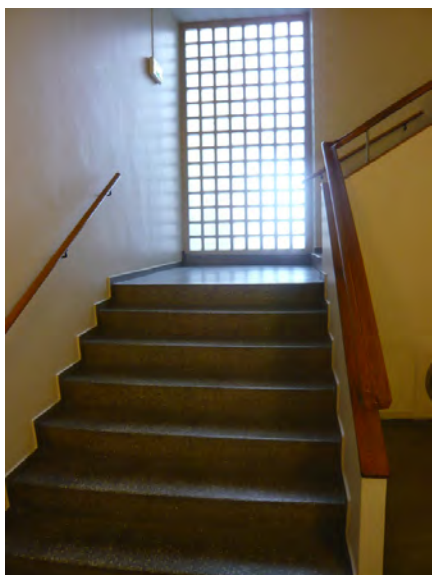
Hovedtrappeløpet. Det er benyttet mye glassbyggerstein for å få lys inn i bygningen. Opphavsrett: Statsbygg.
