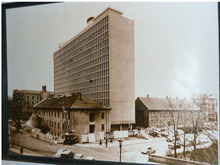
Høyblokken under oppførelse. Rikshospitalets gamle bygninger er ennå ikke revet. Opphavsrett: Statsbygg.
