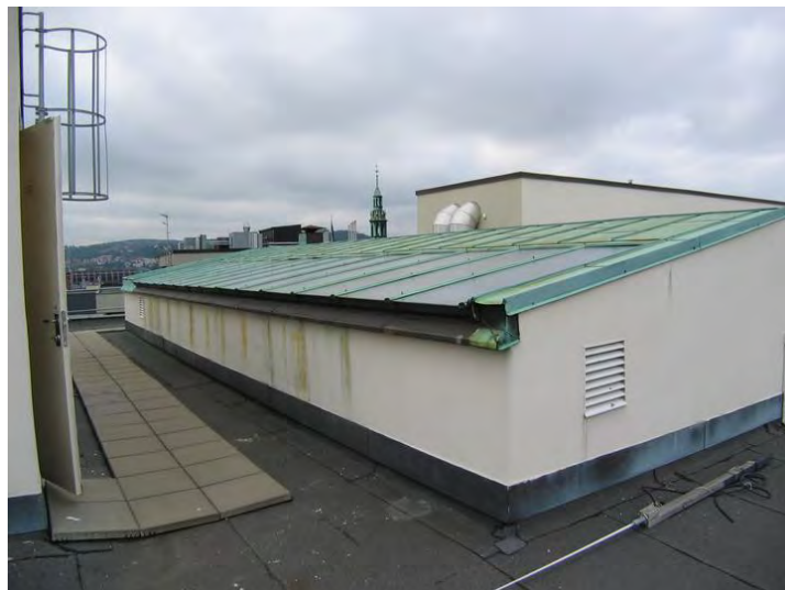
Bildet er tatt på taket og viser overlyset ned i øverste etasje. Overlyset er dekket av trådglass, med kobberbeslag rundt. Opphavsrett: Statsbygg.
