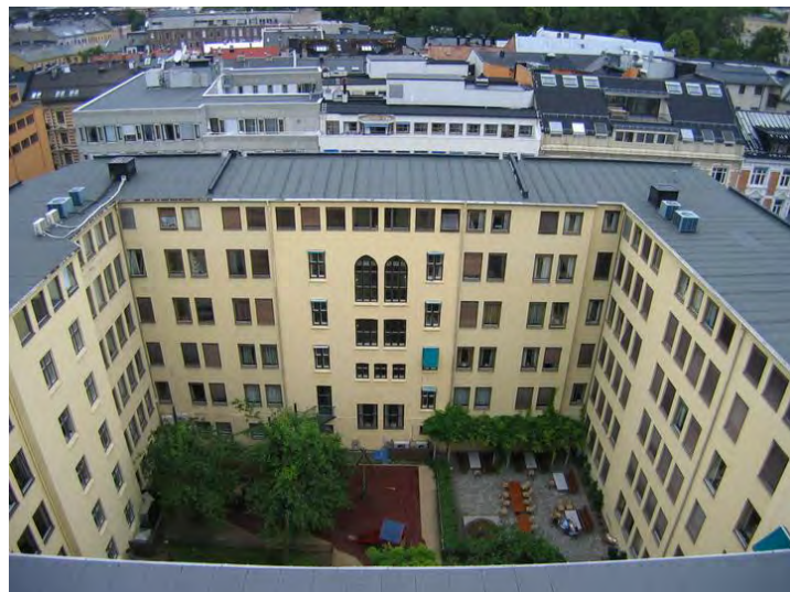
Bakgården sett fra taket. Opphavsrett: Statsbygg.
