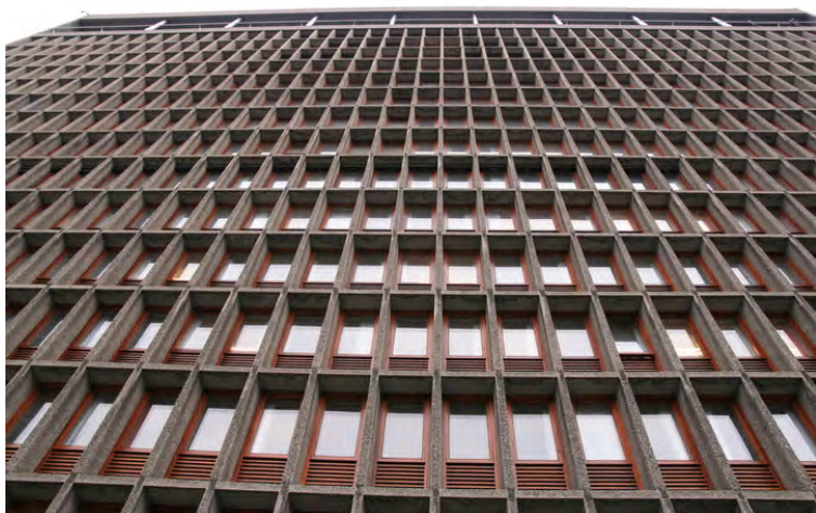
Repeterende ruteraster i fasadene både mot Akersgata og Grubbegata. Vindusfeltene i teak er originale. Opphavsrett: Statsbygg.
