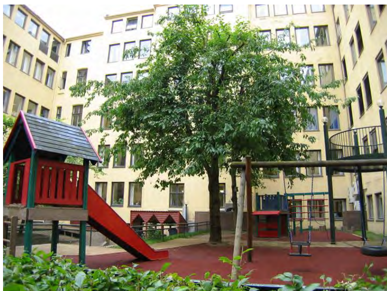
Fasader mot bakgården med barnehagen. Opphavsrett: Statsbygg.
