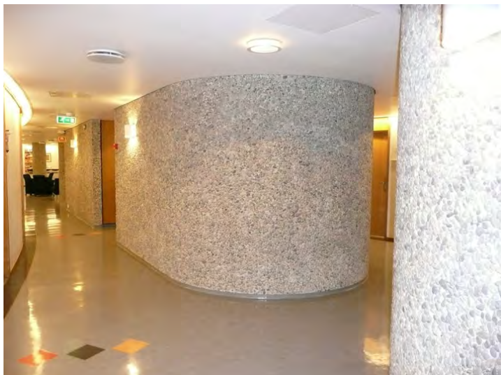
Kjerner med bifunksjoner i korridorene har vegger i naturbetong. Opphavsrett: Statsbygg.
