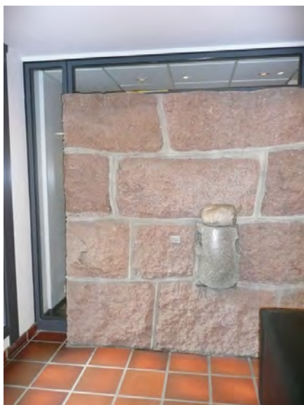
Rester av den gamle fengselsmuren ble plukket ned og murt opp igjen i resepsjonen. Muren omfattes av vernet. Opphavsrett: Statsbygg.
