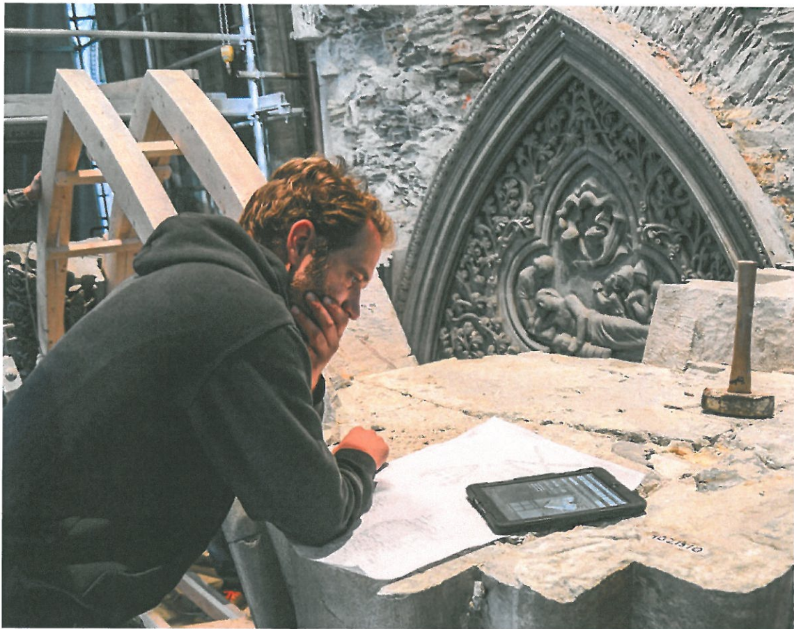
Moderne teknologi benyttes under dokumentasjonen av arbeidene på Kongeinngangen.
