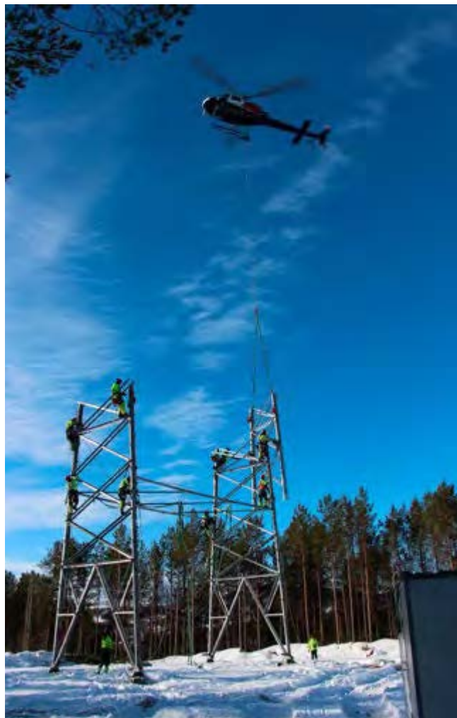
Bygging av ny kraftlinje mellom Balsfjord og Skaidi. FOTO: STATNETT
