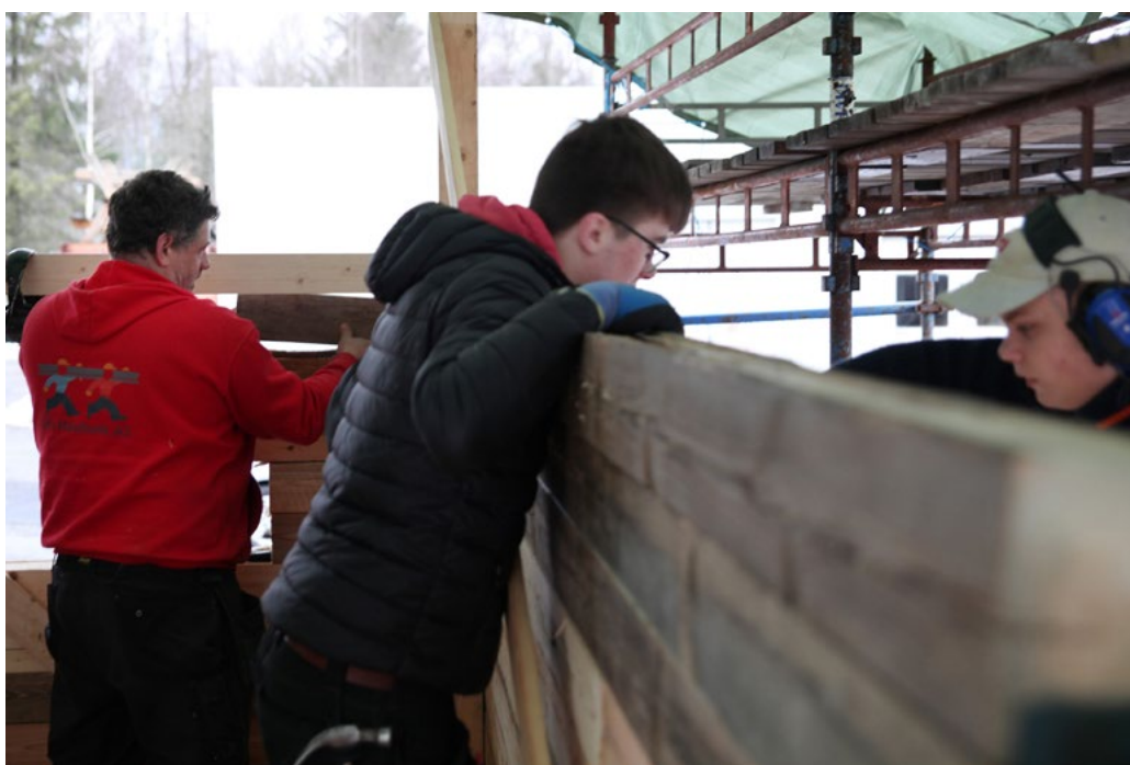
Elevar ved Skarnes VGS i gang med veggkonstruksjon av ombrukstrevirke. Foto: Karen Gjermundrød
