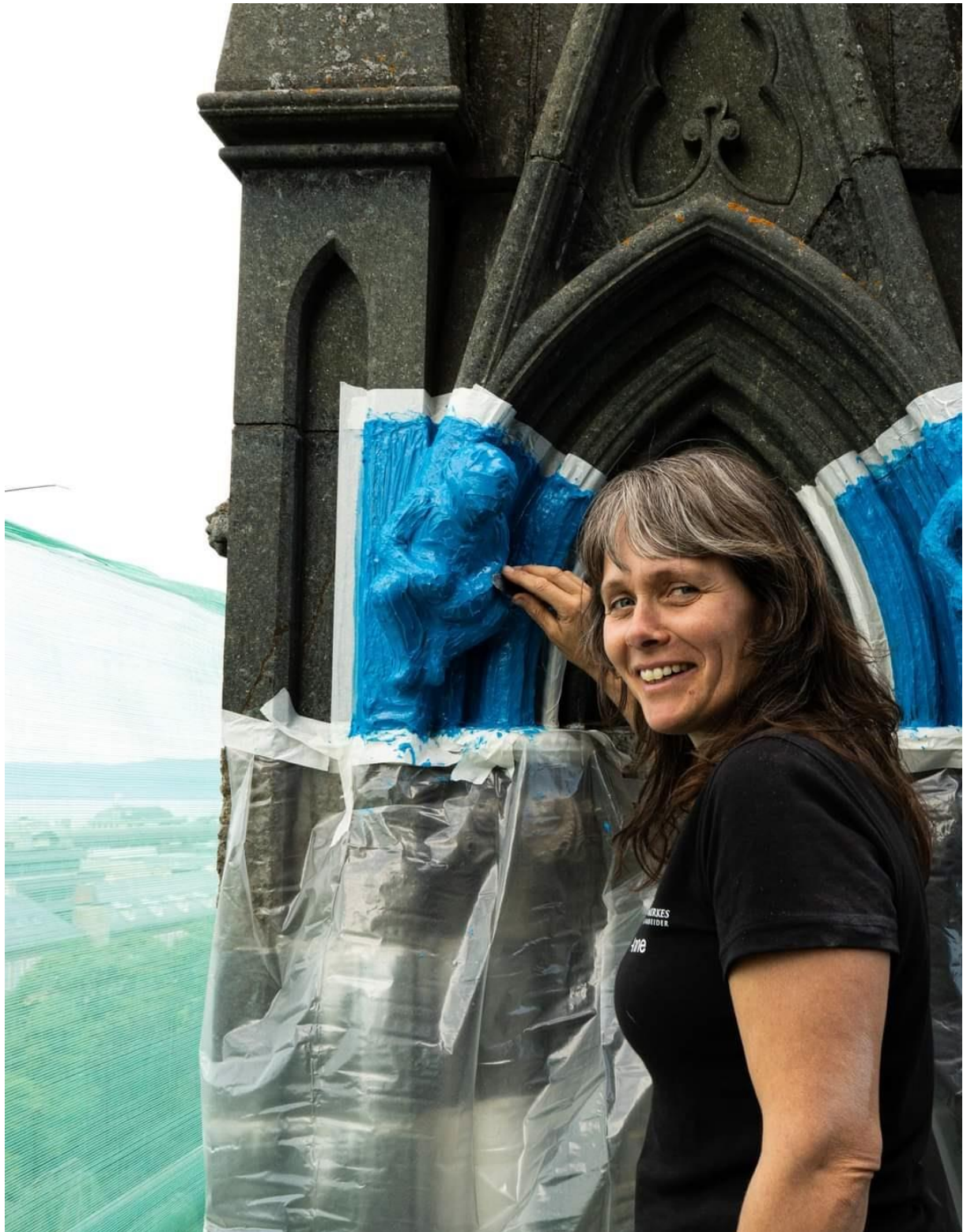
Det lages nye gipsformer høyt oppe på Vestfronten, her ved gipsmaker Anne C. Offergaard.
