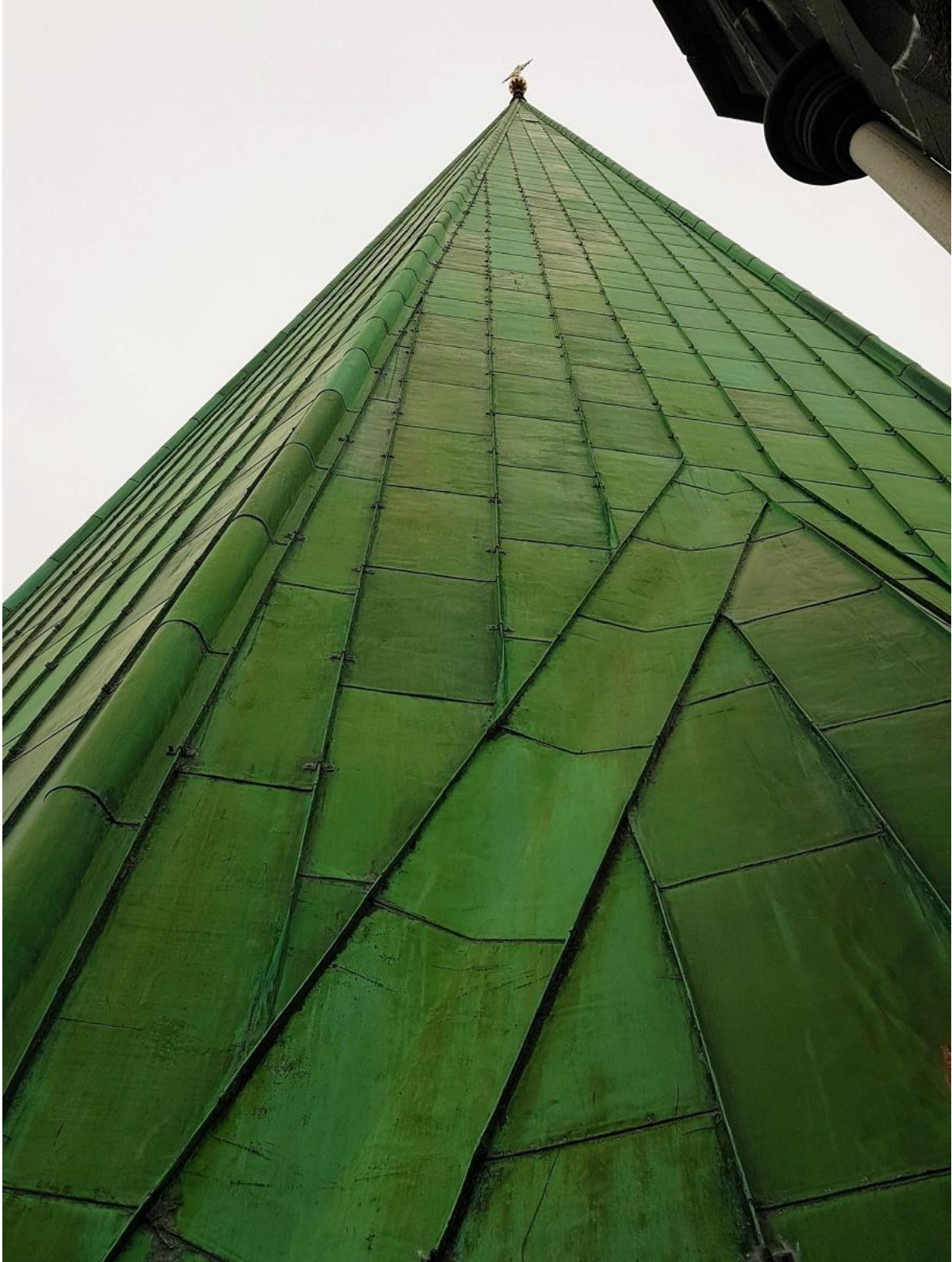
Nidarosdomens spir og spirtopp 87 m over bakken - med det karakteristiske grønne kobbertaket.
