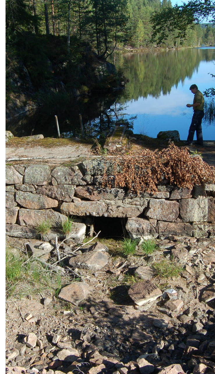
Foto: Glitre vannverk
