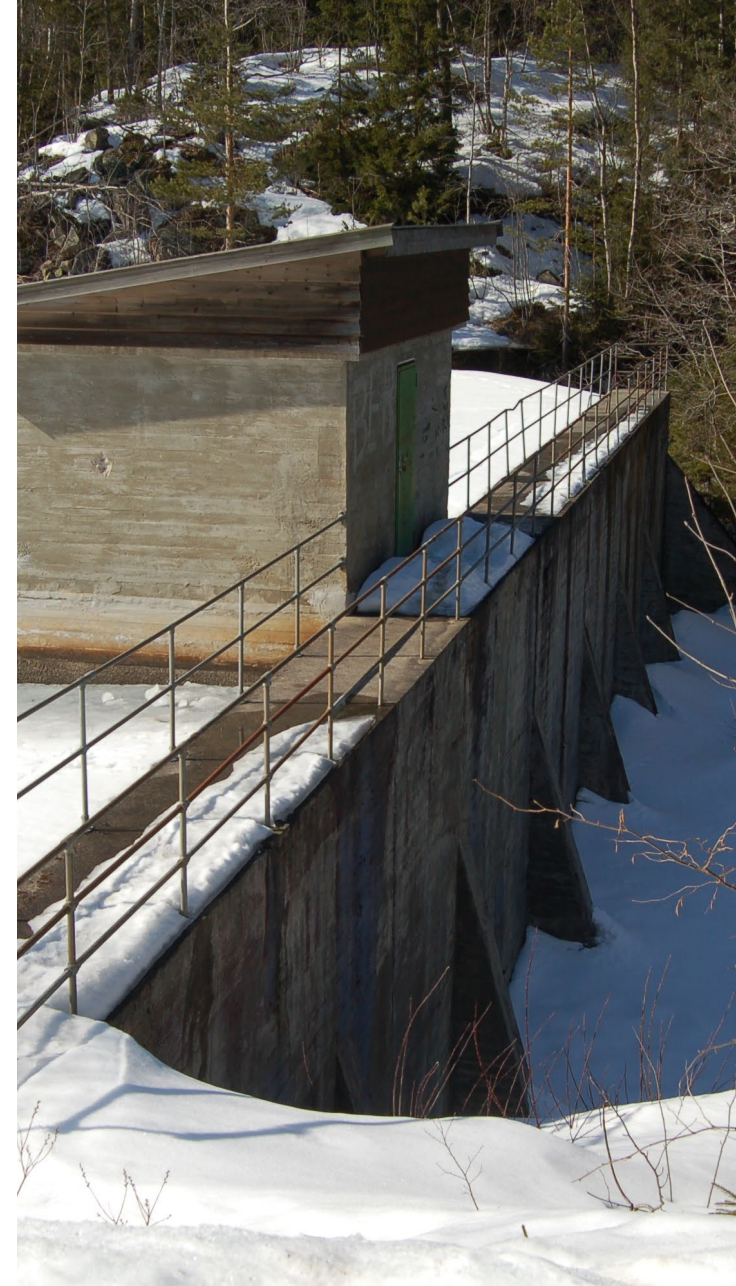
Foto: Glitre vannverk
