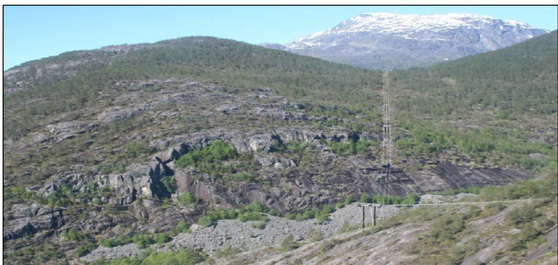
Figur 11. Visualiseringen viser kraftledningstraseen fra Mosnes til Glåmo. Skogryddingsbeltet blir utvidet med ca. 5 meter. I nedre kant av bildet vises spennet over Mosdal. Bilde fra SKL Nett.
