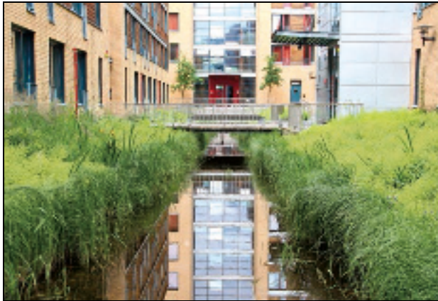
Figur 7.2 Lokal overvannsdiskonering kan fungere som et positivt bomiljøtiltak i tillegg til å forebygge skade
