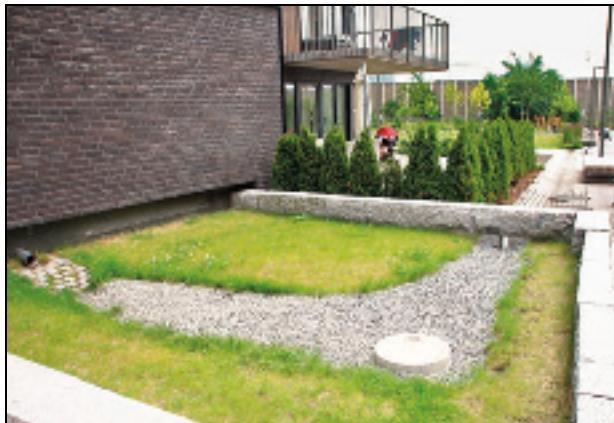
Figur 7.9 Lokal overvannshåndtering, Bertrand Narvesens vei, Oslo
