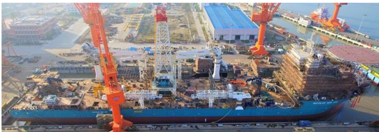
Figur 60 Produksjonsfartøyet "Nautilus New Era" under bygging 22 .
