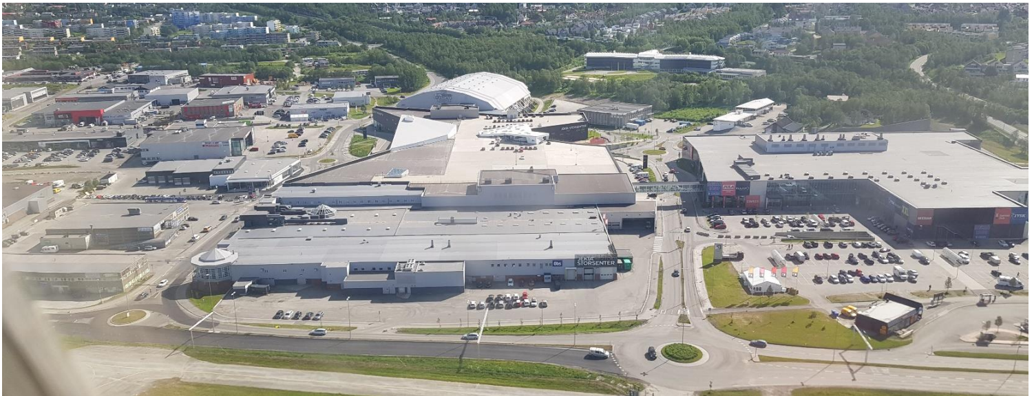
Figur 23: Kjøpesenter og storhandel, Tromsø (Langnes) 2018. Bussterminal t.h. gir deler av senteret god kollektivdekning, mens storhandel t.v. i praksis er bilbasert.
