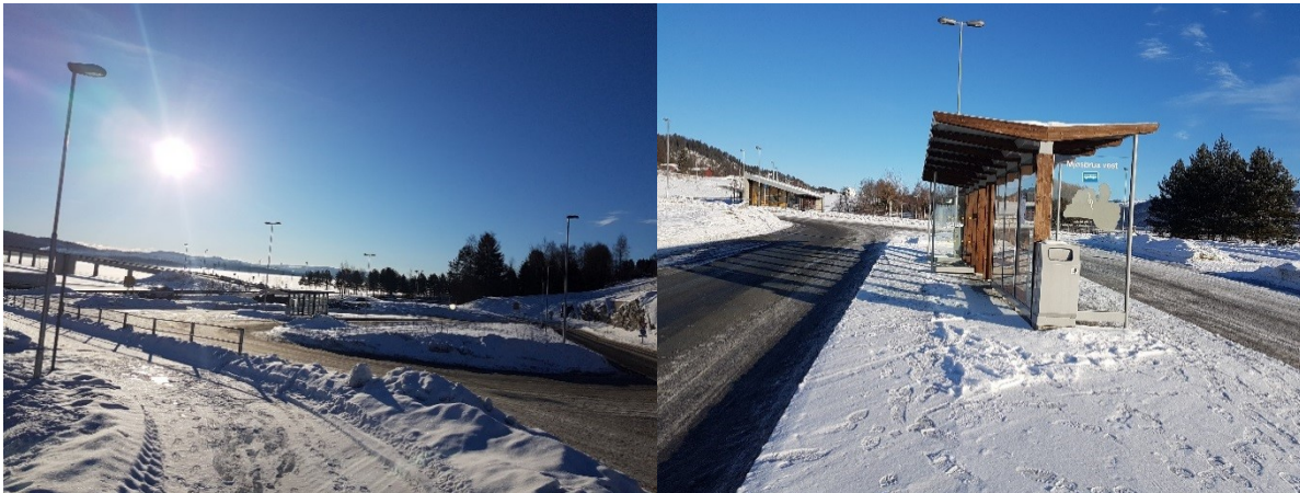
Foto: Håvard Ødegård, Statens vegvesen
