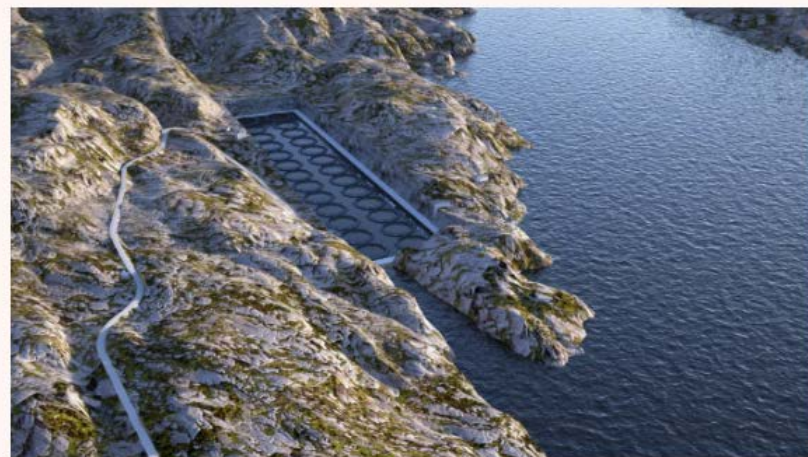
Her, inne i en 410 meter lang fjellhall, vil Losna Seafood etablere oppdrettsbasseng. ILLUSTRASJONSFOTO: Losna Seafood
