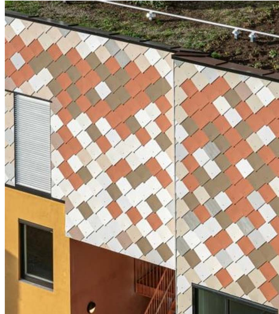
Ombrukshuset Kristians August gate 13, Oslo Entra
