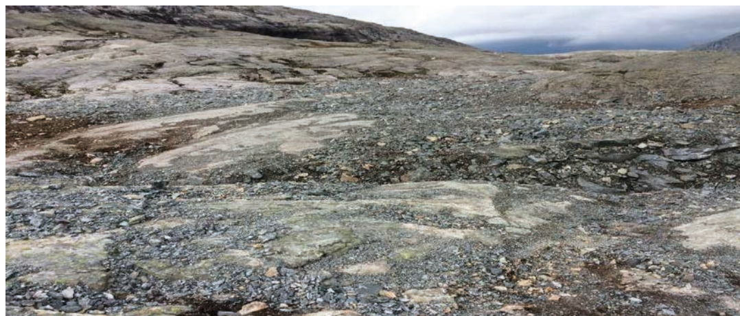
Figur 2. Deponering av sprengde masser i søkk i terrenget.
