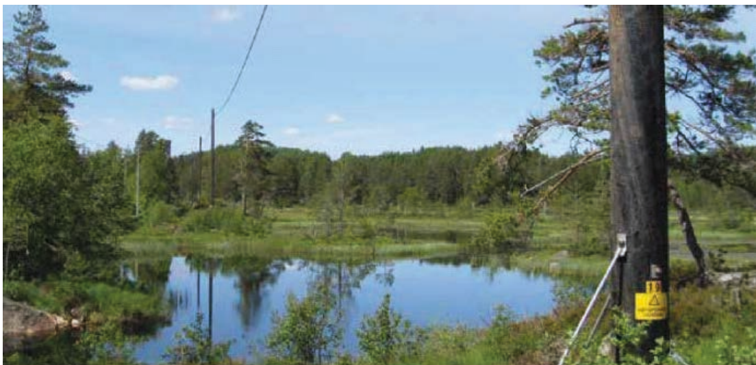
Figur 4. Illustrasjon av typisk spennlengde og ryddebelte for omsøkt hengekabel. Kilde: Søknad.
