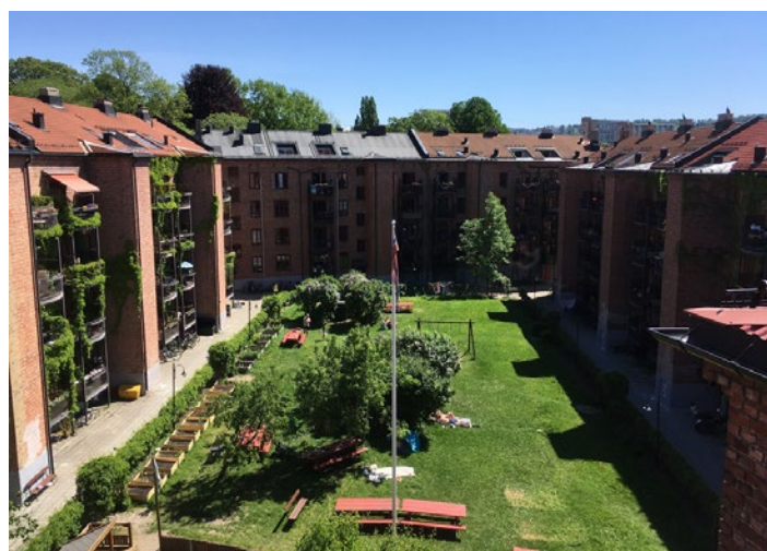
Gråbeinkvartalet på Tøyen i Oslo, opprinnelig bygget rundt 1890, ble oppgradert gjennom byfornyelse på 1980-tallet med blant annet nye bad, balkonger, sammenslåing av leiligheter og sanering av bakgårdsbebyggelsen. Foto: Eli Støa
