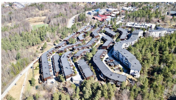
Hallagerbakken, Holmlia, Oslo, HRTB-arkitekter, 1981. 93 leiligheter i blokker, 126 rekkehus. Foto: Wikipedia Creative Commons.
