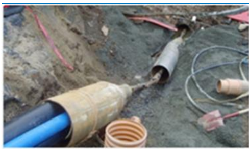
Figur 3-12: Utblokking og inntrekking av to rør
