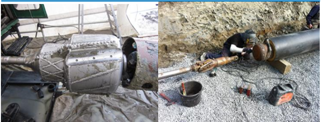
Figur 3-16: Montering rømmekrone og medierør
