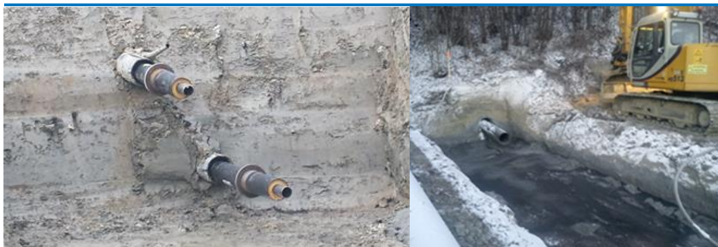
Figur 3-17: Ferdig tilbaketrasket rør
