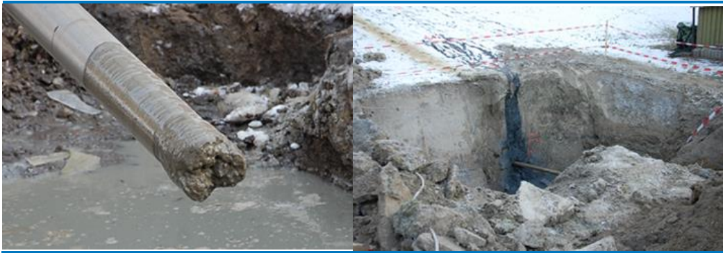
Figur 3-16: Montering rømmekrone og medierør
