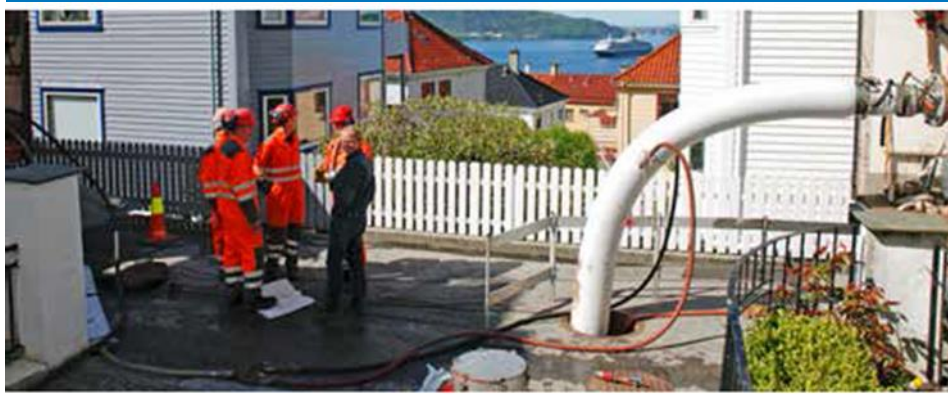
Figur 3-18: Rehabilitering av AF avløpsledning med strømpeforing
