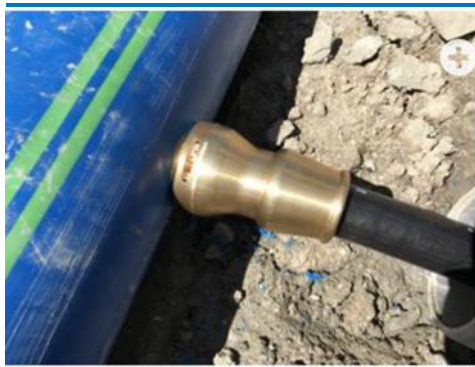
Figur 3-22: Stikkledning etter tilkobling
