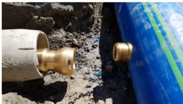
Figur 3-21: Stikkledning før tilkobling
