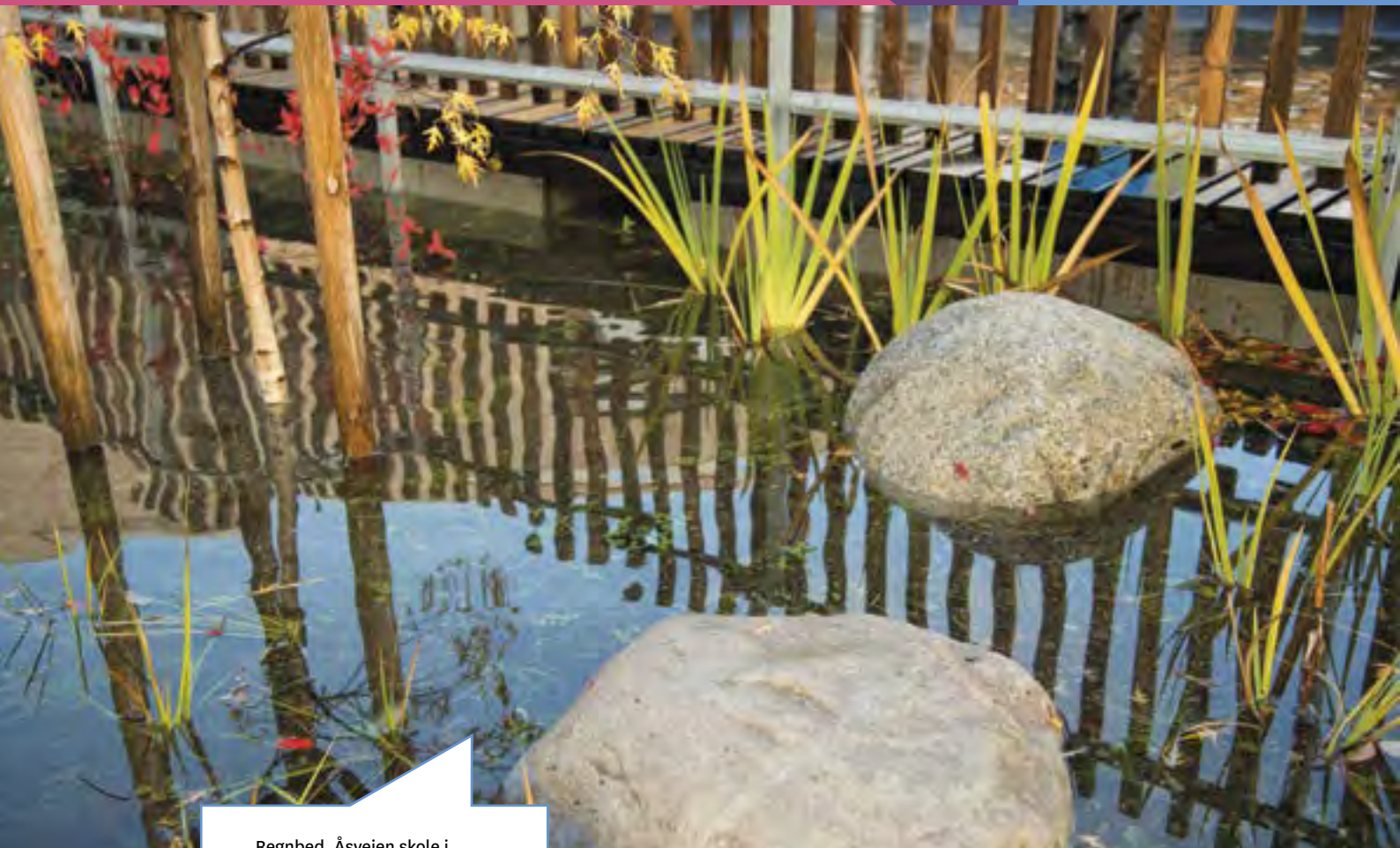
Regnbed, Åsveien skole i Trondheim. Et pilotprosjekt i Framtidens bygg.
