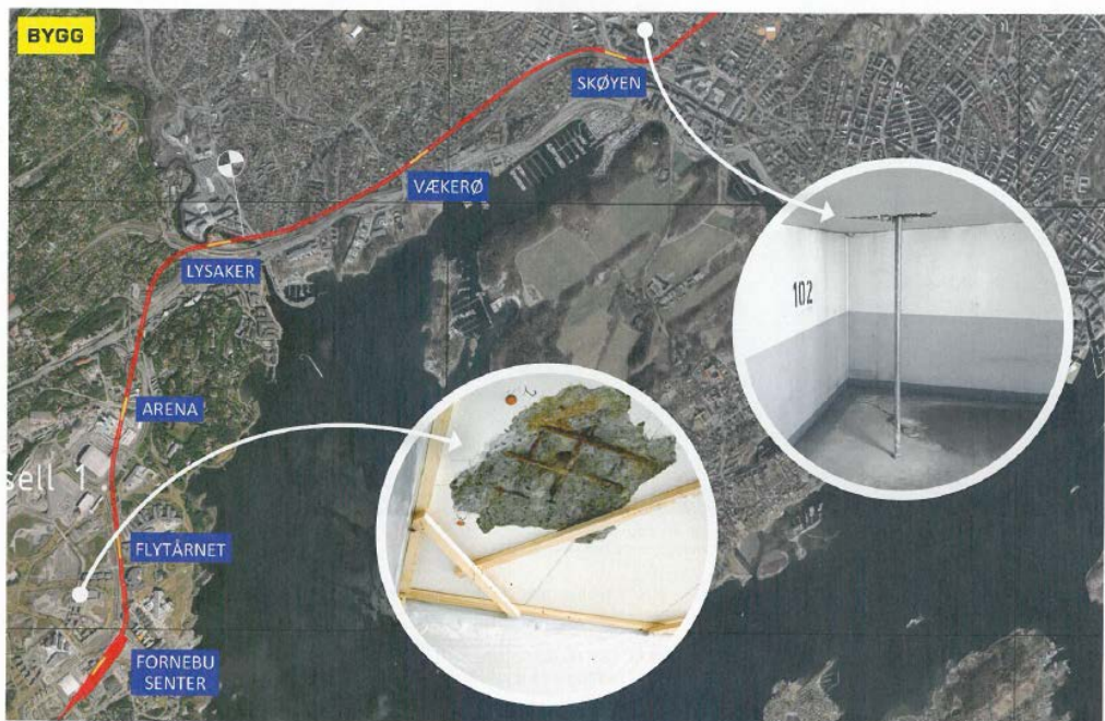
Borebom: Fornebubanens boreentreprenør ble utstyrt med kart som ikke var oppdaterte da de skulle bore for å installere poretrykksmålere langs traséen. Det resulterte i at de boret hull i to private garasjeanlegg. FOTO: TUVA STRØM JOHANNESSEN, THOMAS HANEBOG/OSLO KOMMUNE (KART)
