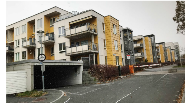
Gangveien forbinder lamellbyggene med grøntdraget.
