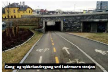
Gang- og sykkelundergang ved Lademoen stasjon
