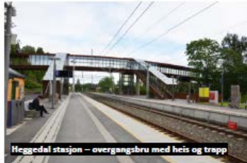
Heggedal stasjon – overgangsbu med heis og trapp
