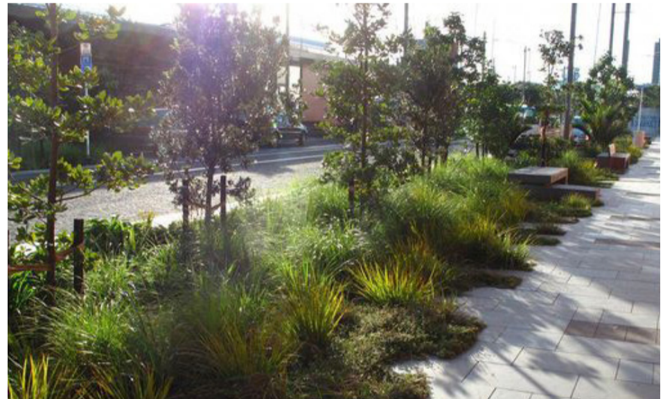
Regnvannsgrøft i gaterom,
