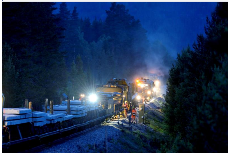
Svillbytte på Rørosbanen. Foto: Øystein Grue
