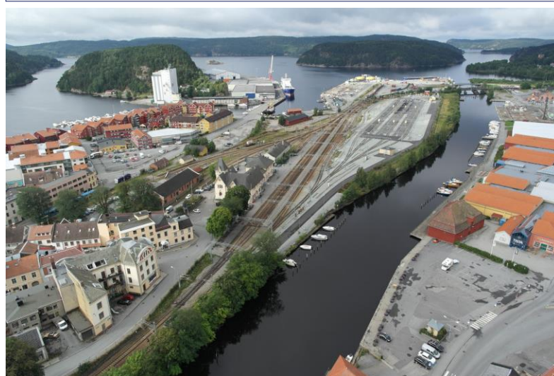
Flyfoto av Halden stasjon.
