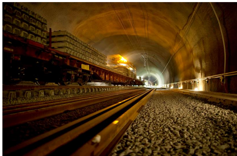
Skinnelegging i Bærumstunnelen. Foto: Hilde Lillejord.
