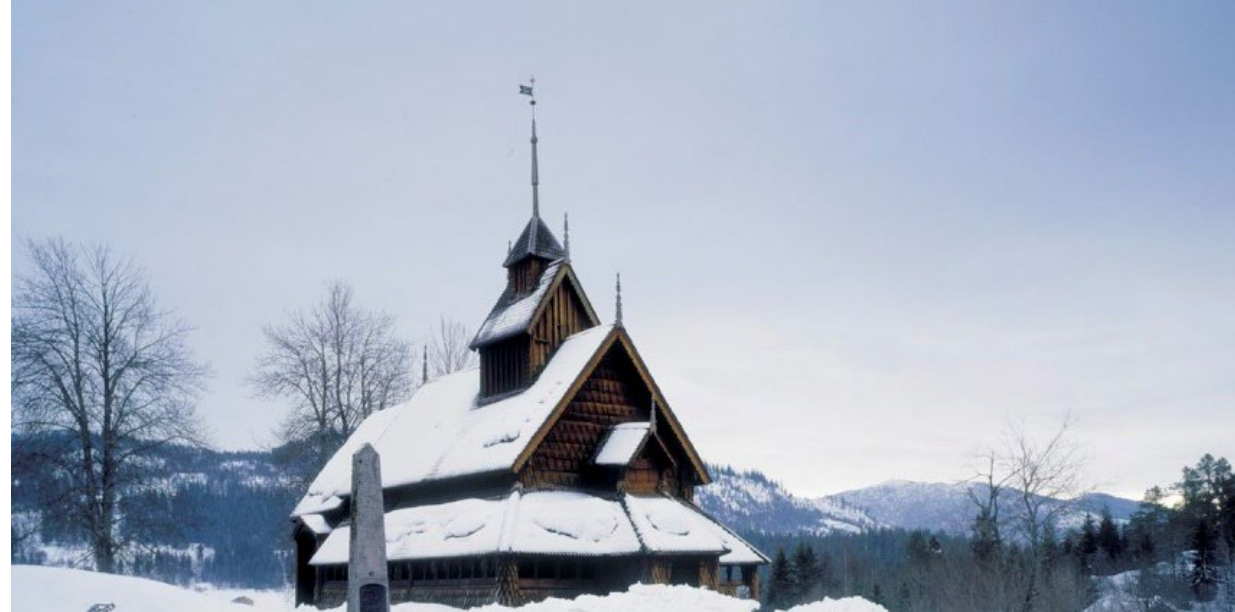
Eidsborg Stavkirke, Tokke. Foto: Jiri Havran, Riksantikvaren
