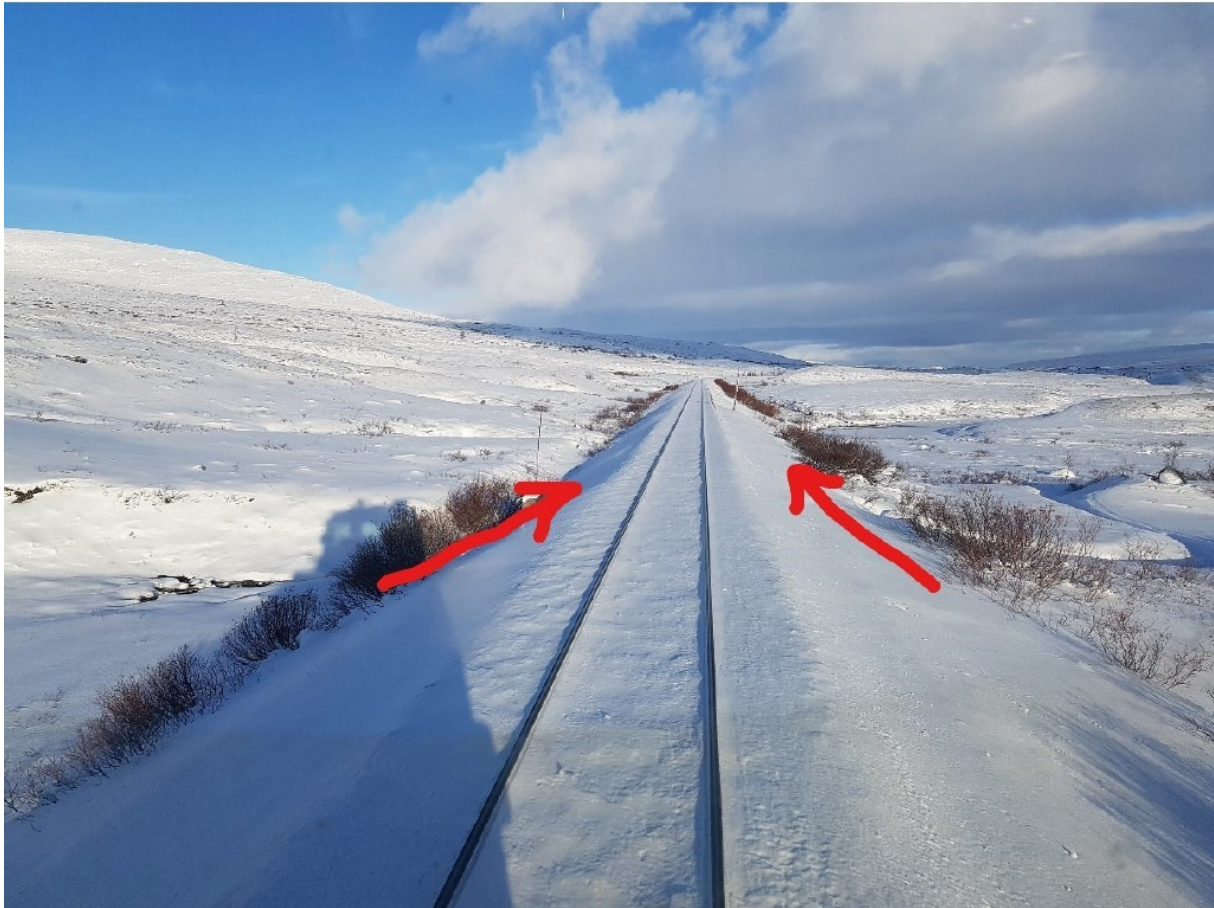
Figur 6.9 Jernbanetraseen (her over Saltfjellet) er ofte det høyeste punktet i umiddelbar nærheten når reinbeiter i området langs strekningen. Reinen bruker den islagte Lønselva (til høyre i bildet) for å krysse, eller benytter seg av snøbrøytet spor som en enkel korridor i landskapet. Ved skremming hopper dyrene opp på linja, gjerne i flokk (etter Wagner m.fl. 2019). (Foto: Gabriela Wagner).
