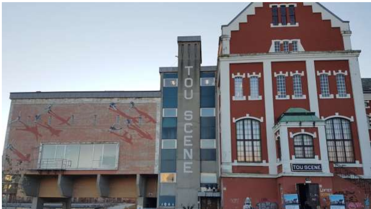
Figur 4.48 Tou Scene: kulturliv i gamle bryggerilokaler i sentrum øst, områdeutvikling med renovering og nybygging.
