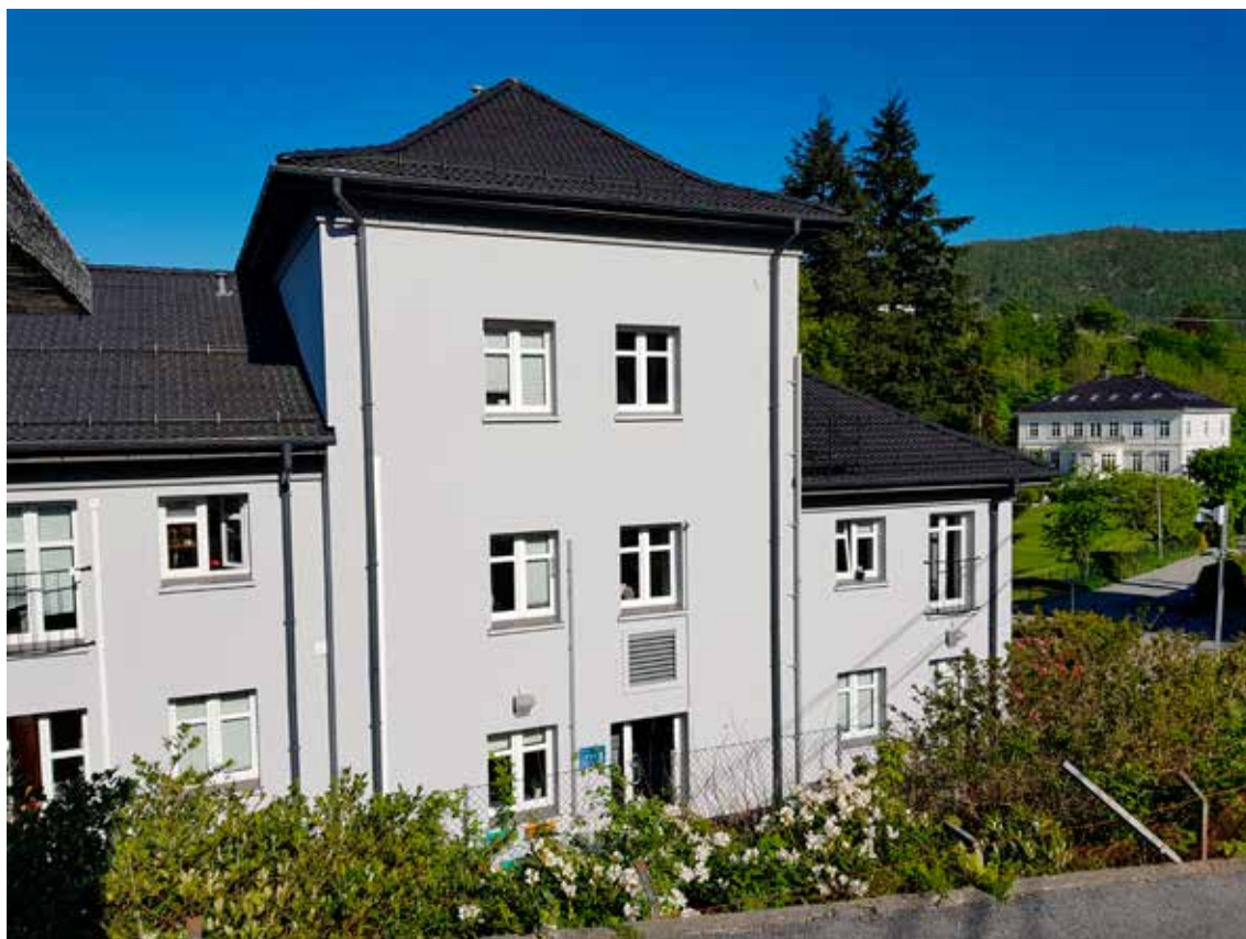
Lyderhorn Overgangs bolig, Laksevåg, Bergen
