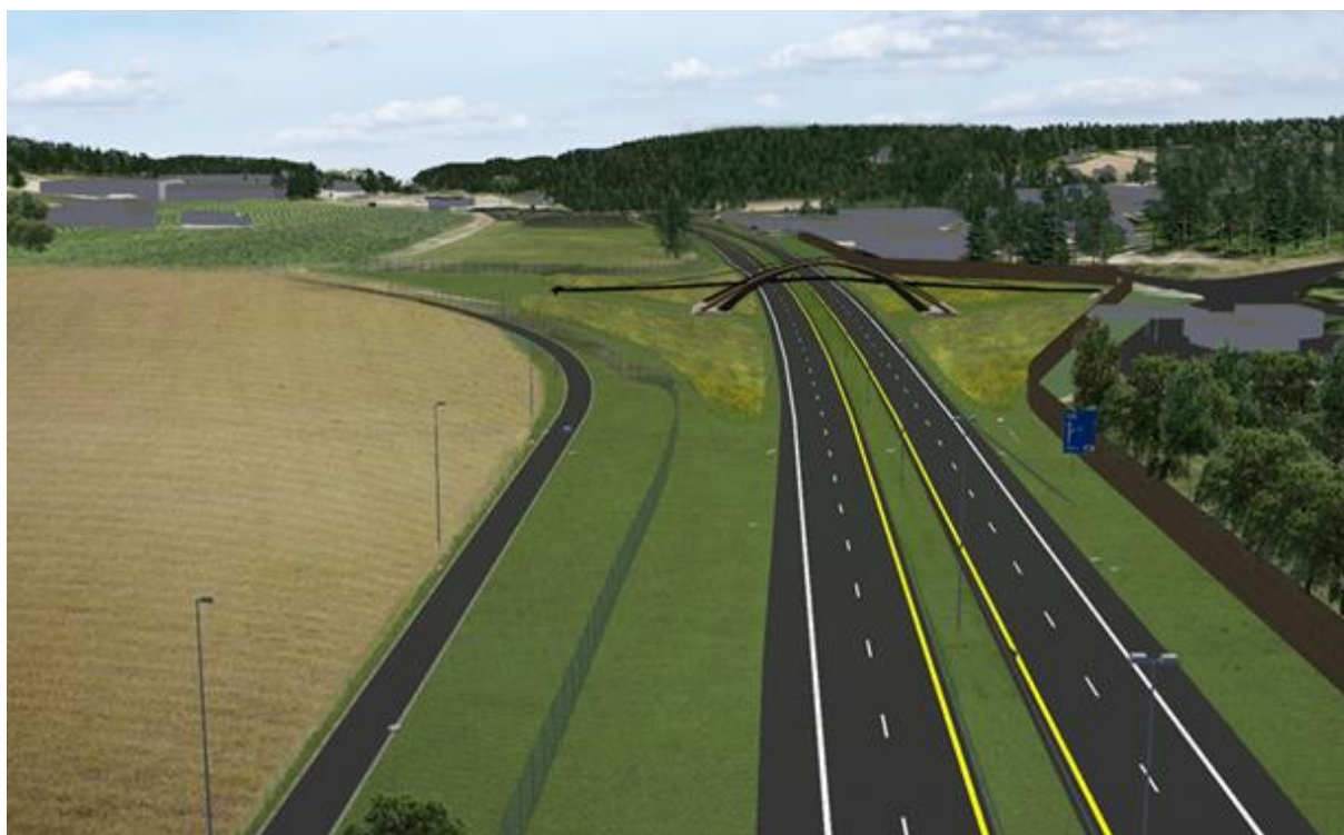
Figur 2. Ny firefelts E18 – her senkes veien under den eksisterende Da Vinci-broa. Boligmassen skjermes mot støy med støyskjermer.
