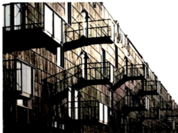
Egenes park, Stavanger. HLM arkitekter. Balkongene underbygger det stramme uttrykket.
