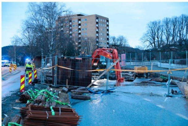
Lekkasjen stammet fra denne gropen, der man tydelig kunne se at det seg opp vann. Olav Olsen
