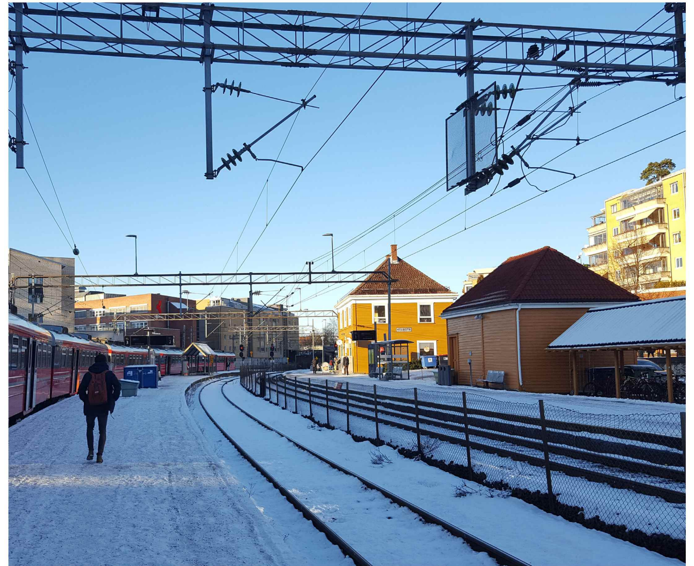
Stasjonsbygningen og pakkhuset sett fra midtplattformen ved spor 2 og 3.
