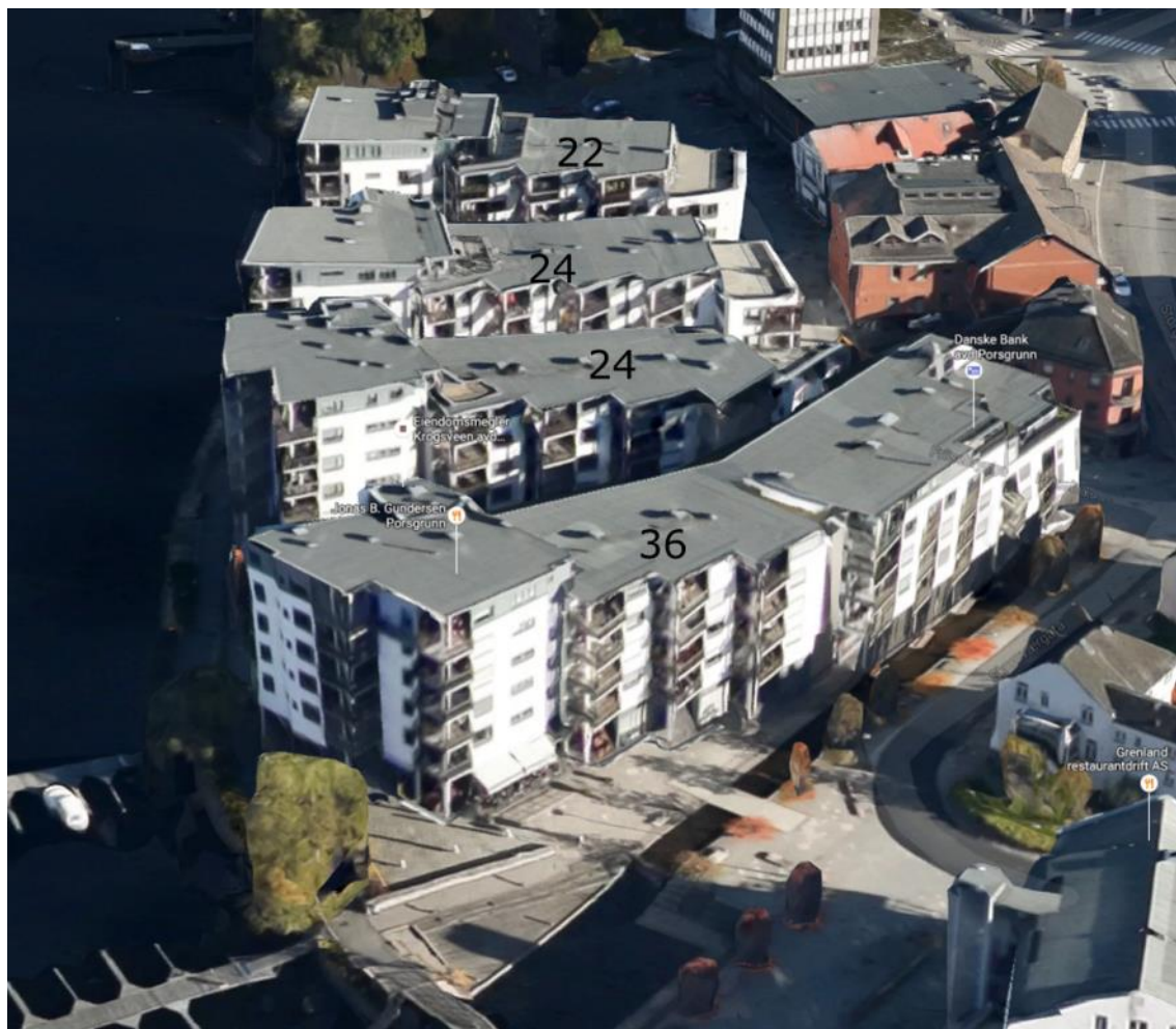
Figur 27: Bratsberg brygge Porsgrunn. 11 boenheter per daa + næring i 1. etg. Antall enheter plassert over hvert bygg.
