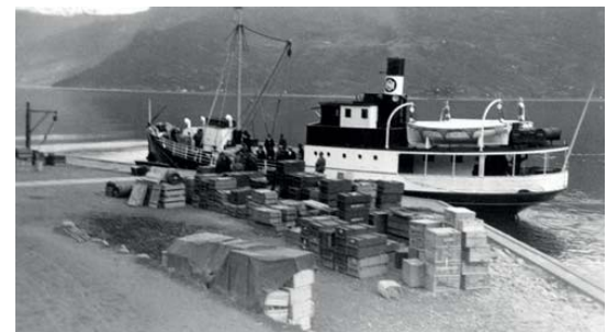
Bilde 10. Dampen på kaia. Mottatt av informant. Tilhører bildesamlingen til “Vikebygdkrinsen”
