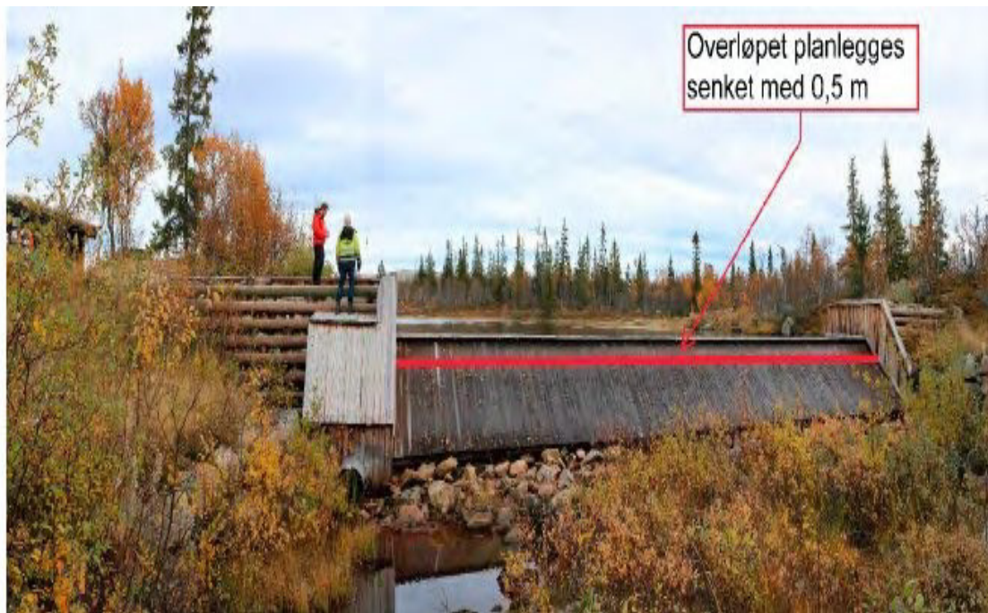
Figur 3. Tømmerkistedammen ved Store Hyllsjø planlegges bygget om ved å senke overløpet med 0,5 m. Den røde linjen illustrerer ca. høyde på overløpet etter ombygging. Det planlegges benyttet tilsvarende byggematerialer som i dag, slik at dammens estetiske uttrykk bevares. Bildet er hentet fra søknaden.
