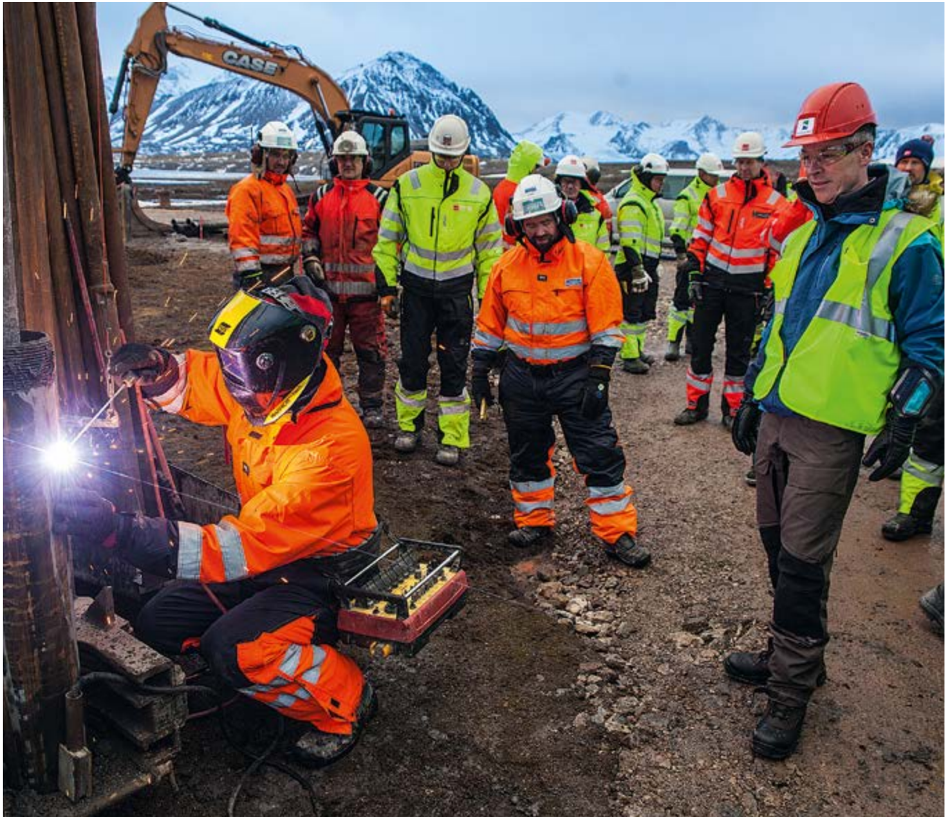
En av de store milepælene for Kartverket i 2014 var markeringen av byggestart for det nye geodetiske jordobservatoriet i Ny-Ålesund 4. oktober, hvor kommunal- og moderniseringsminister Jan Tore Sanner var tilstede.
