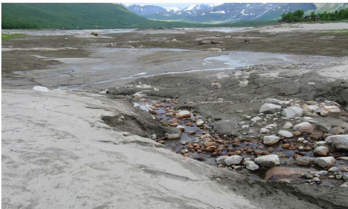
Figur 5. Storvatnet 30.6.2008 sett mot Sjursheim og indre Håkvikdalen. Stein med pil viser vannstands nivå 253,2, dvs. 5,4 m under HRV (gammelt høydesystem.) (Foto: NVE).
