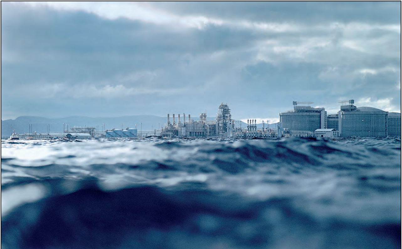
Figur 5.8 Utbyggingen av Snøhvit-feltet med det tilhørende LNG-anlegget på Melkøya har gitt befolkningsvekst og økte skatteinntekter til Hammerfest kommune. Snøhvit er den første utbyggingen på norsk sokkel uten installasjoner på overflaten.
