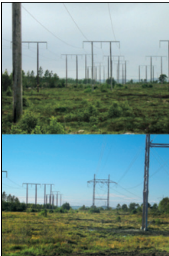
Figur 6.5 Det øverste bildet er situasjonen før 420 kV-ledningen ble etablert. Det nederste bildet viser 420 kV-ledningen som NVE ga konsesjon til, og som sammen med ny Fræna transformatorstasjon gjorde det mulig å sanere to regionalnettsledninger
