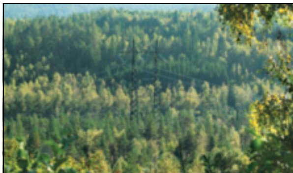
Figur 6.8 420 kV ledning Viklandet – Fræna. Eksempel på kamouflering og begrenset skogrydding
