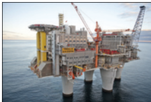
Figur 3.10 Troll A-plattformen var den første installasjonen på sokkelen som fikk kraft fra land
