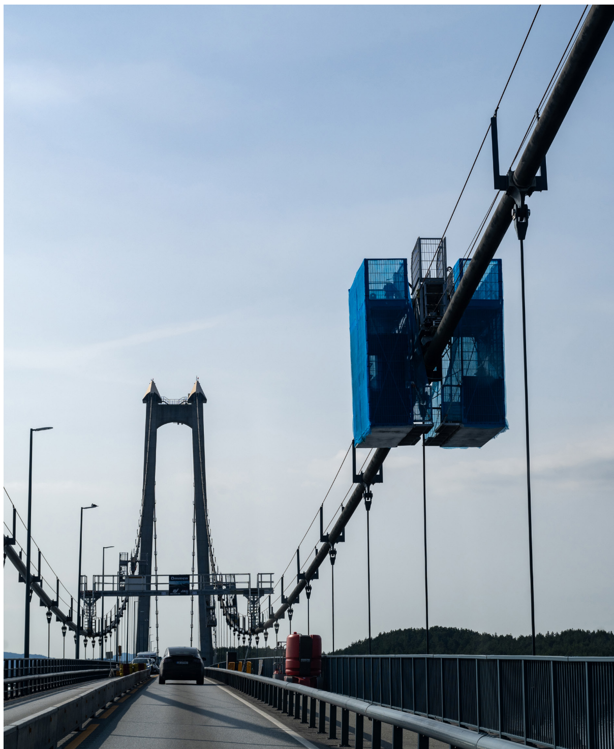
Vedlikehold av E39 Stordabrua. Foto: Bård Asle Nordbø, Statens vegvesen
